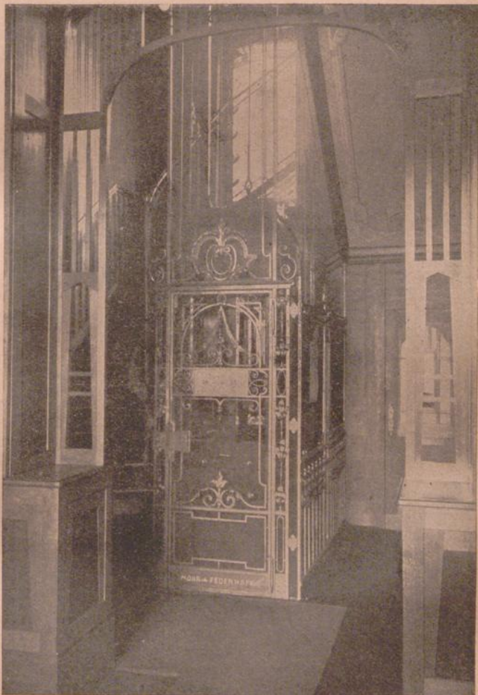
Elektrischer Personenaufzug mit Druckknopfsteuerung
