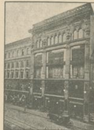
Ansicht des neuen Hauses
