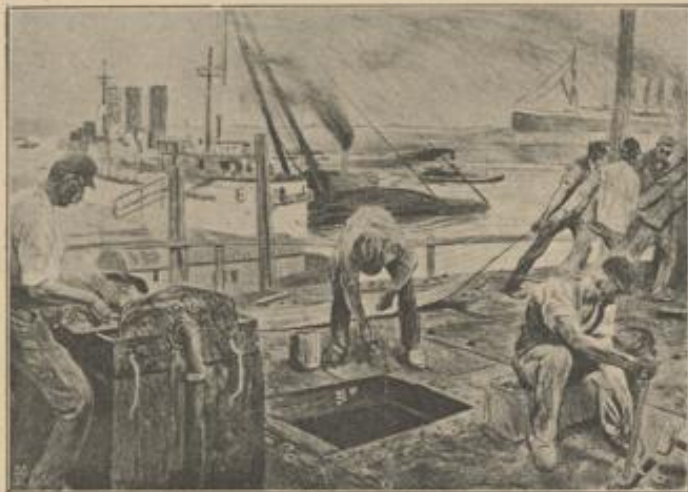
Ludwig Deitmann: Im Sulfanwerk bei Stettin.
