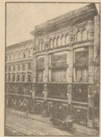
Ansicht des neuen Hauses
