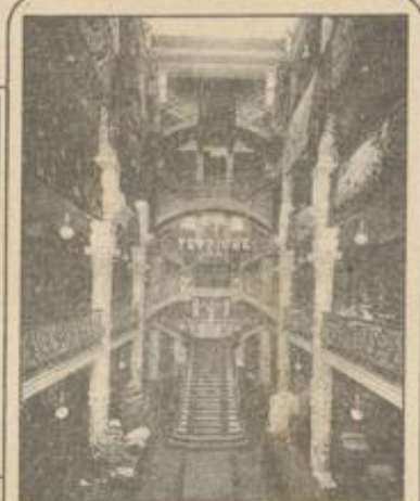
Innere des neuen Hauses
