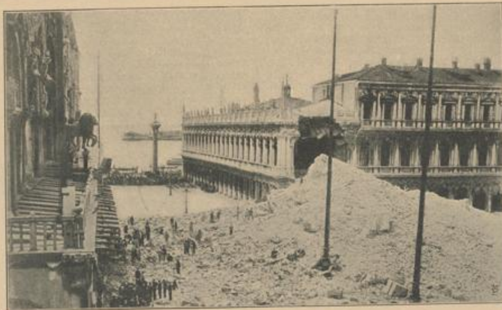
Der Campanile in Venedig nach dem Einsturze. Nach einer Photographie von R. 310.
