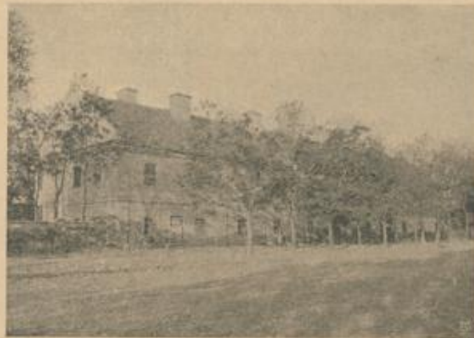
Lenaus Geburtshaus in Gjatah bei Trnedoör.
