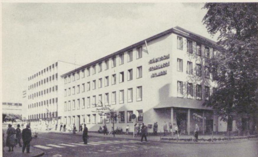
Gebäude der Städtischen Sparkasse Opladen
