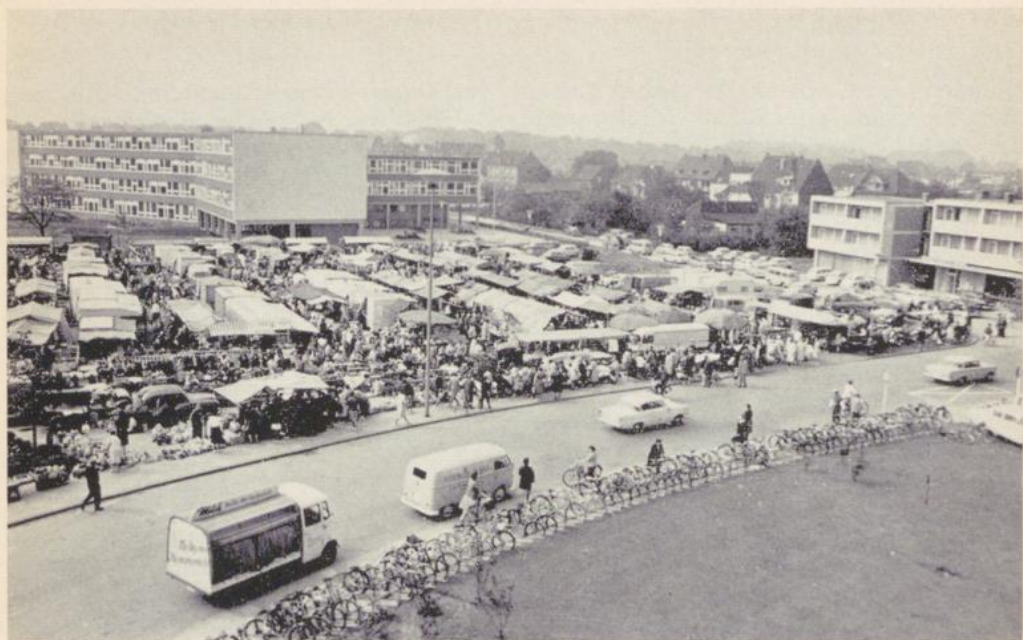
Wochenmarkt mit Blick auf das neue Landrat-Lucas-Gymnasium
