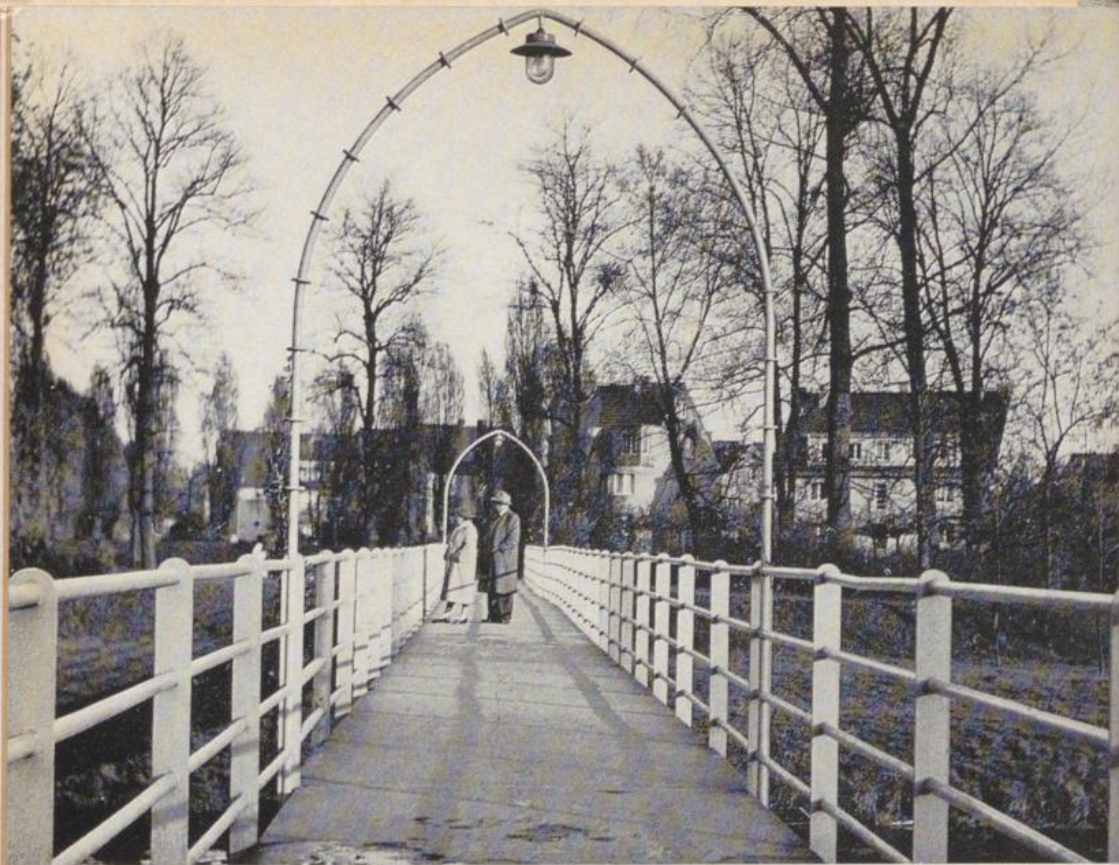
Brücke über die Wupper
