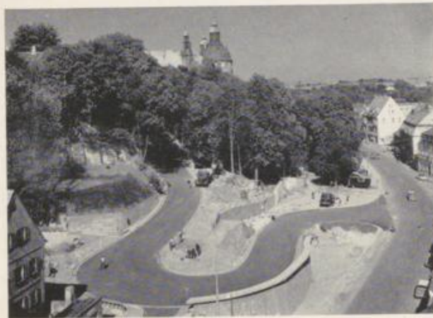
Neue Stadbergauffahrt Luitpoldstraße-Obere Stadt, erbaut 1963/64. Foto Sayle, Neuburg
