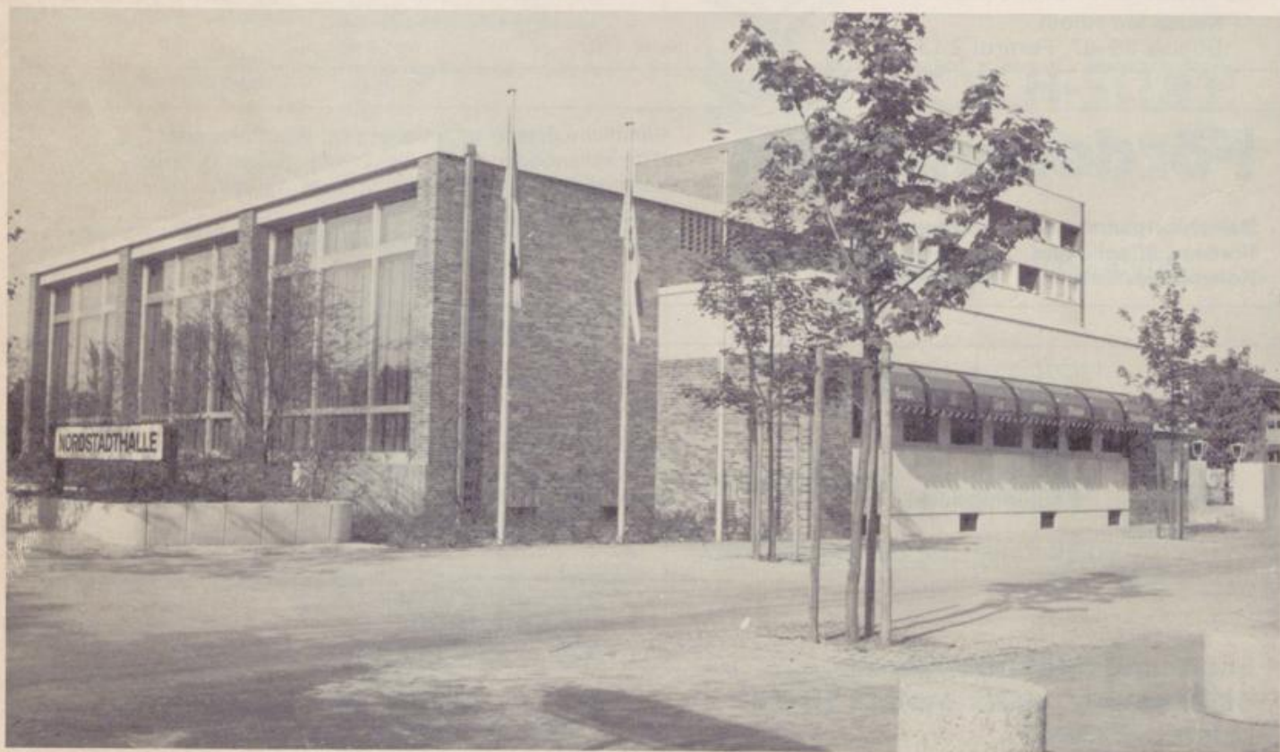
Nordstadthalle im Stadtteil Furth 1975 erbaut
