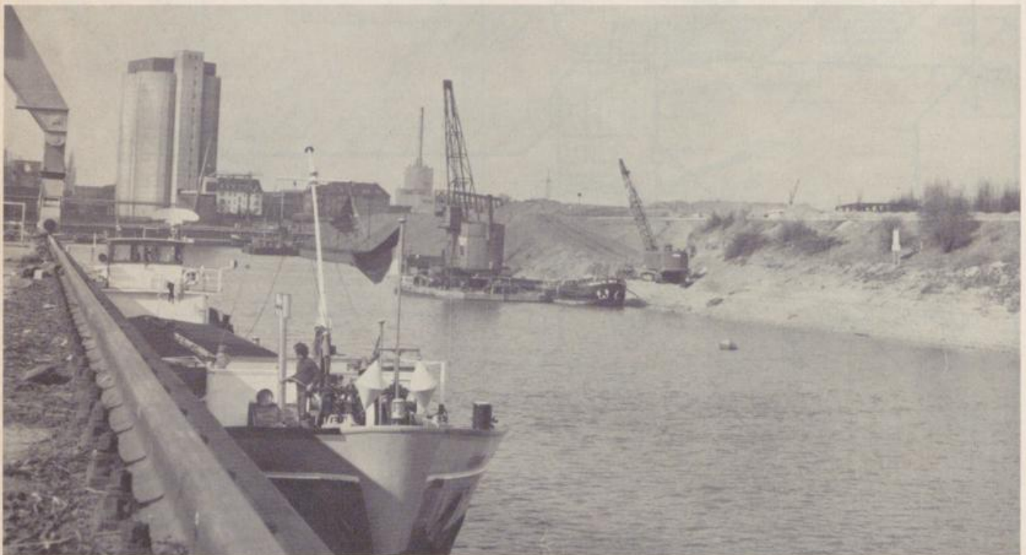
Ausbau des Hafenbeckens 5
