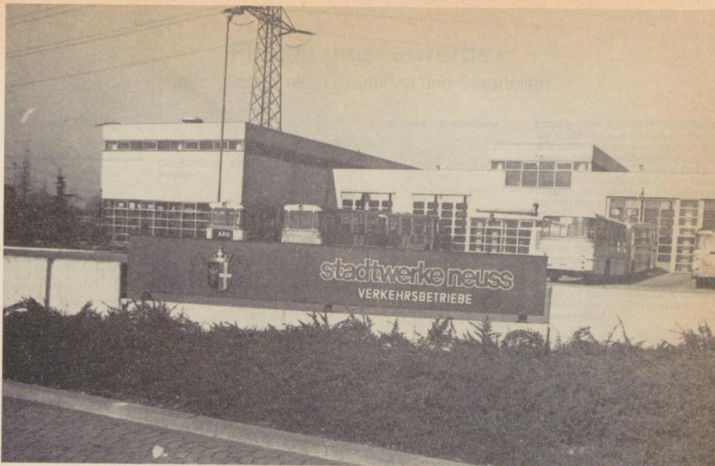
Verkehrsbetriebe Betriebshof Moselstraße
