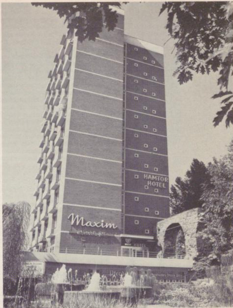
Hamtor-Hotel am Hamtorwall (eines der ersten Wohnhochhäuser)
