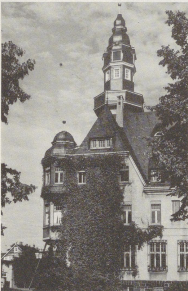
Rathaus in Remscheid-Lüttringhausen
