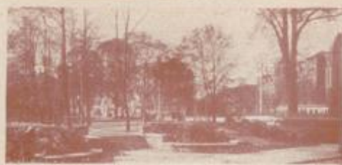
Grünanlagen Hauptbahnhof - Südeingang
