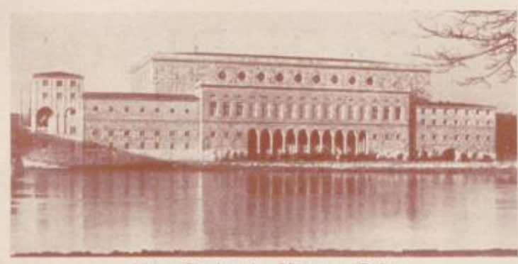
Neue Stadthalle, Mülheim (Ruhr) mit vollständig unsichtbarer Blitzschutzanlage.
