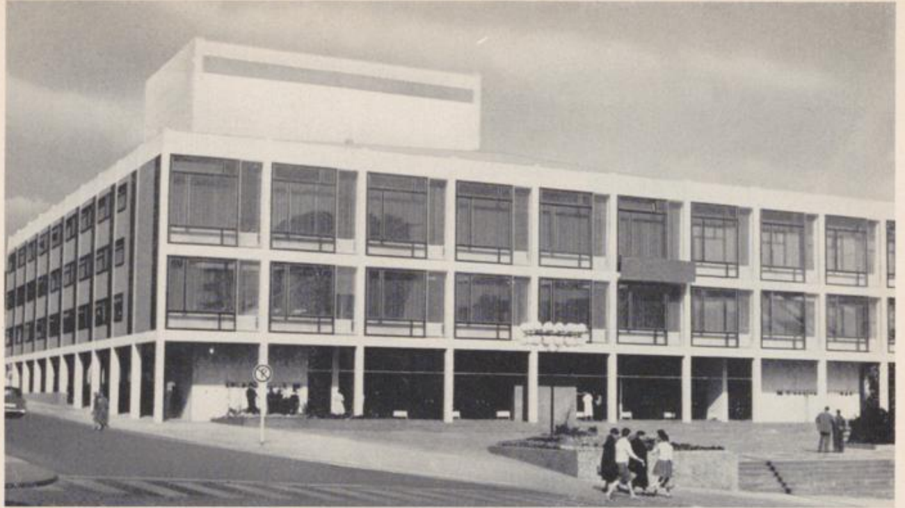
Stadttheater — der Neubau an der Hindenburgstraße
