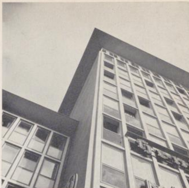
Blick zum elfgeschossigen Turm von „Haus Westland“ gegenüber dem Hauptbahnhof
