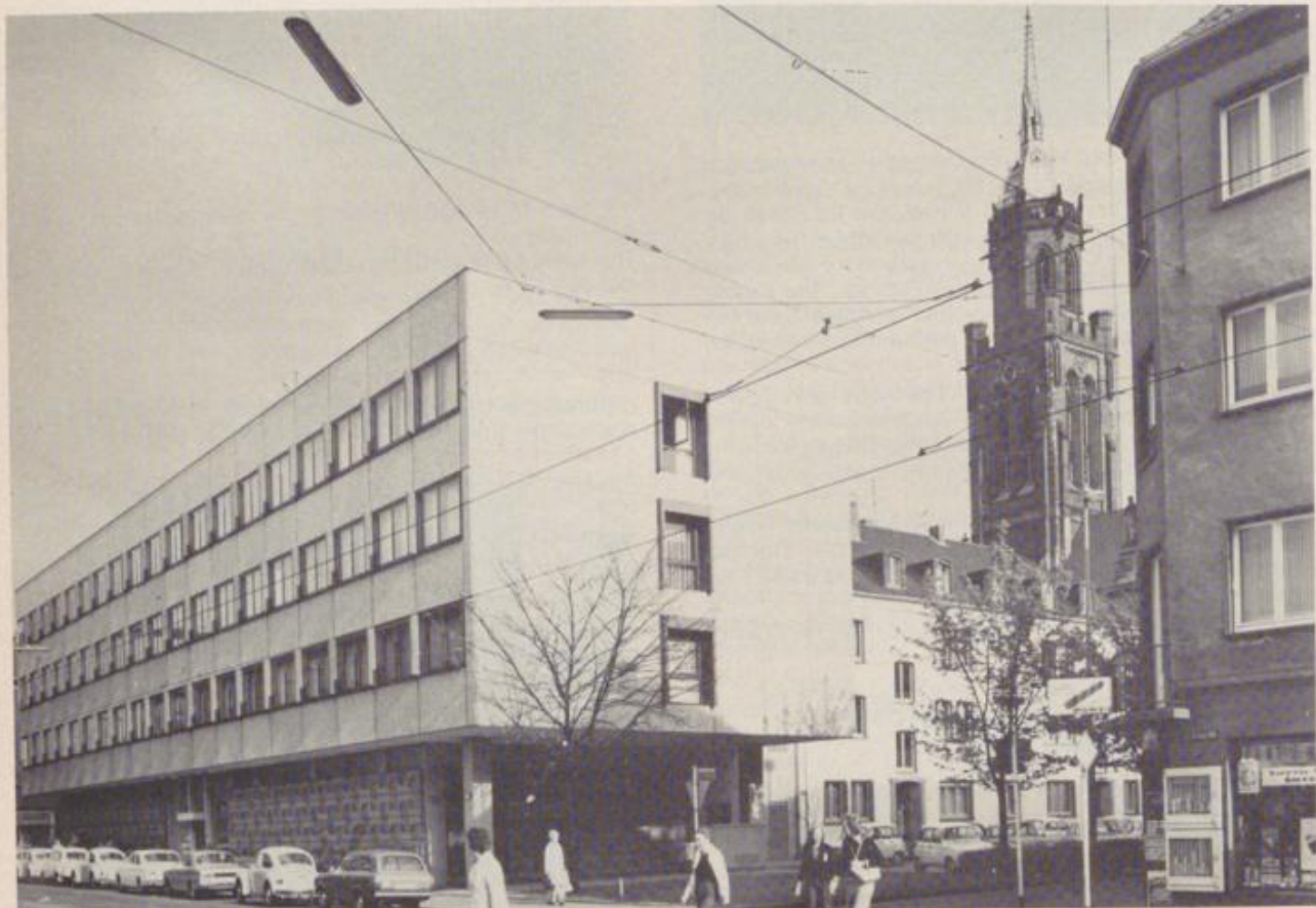
Papst-Johannes-Haus: Mit seiner langgestreckten Front an der belebten St.-Anton-Straße und dem Rathaus der Stadt gegenüber gibt es auf seiner Hofseite den Blick frei zur Hauptpfarrkirche St. Dionysius.
