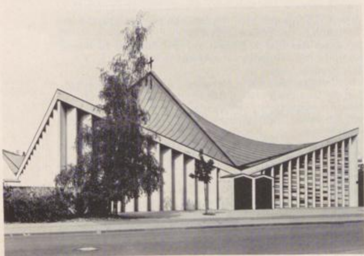
St. Pius X., Gartenstadt, 1968, Neubau über quadratischem Grundriss mit Dachkonstruktion in Schalenbauweise.
