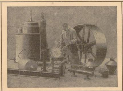
Wir bauen als Spezialität stationäre Acetylengas-Erzeugungs-Anlagen bis zu 2000 Kilo Carbid Tagesverbrauch
