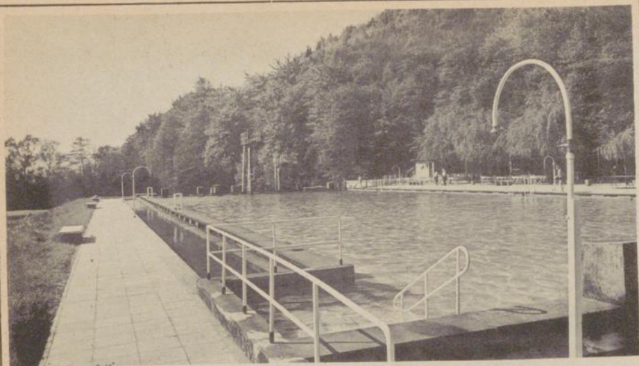
Waldfreibad im Nizzatal mit moderner Wasseraufbereitungsanlage
