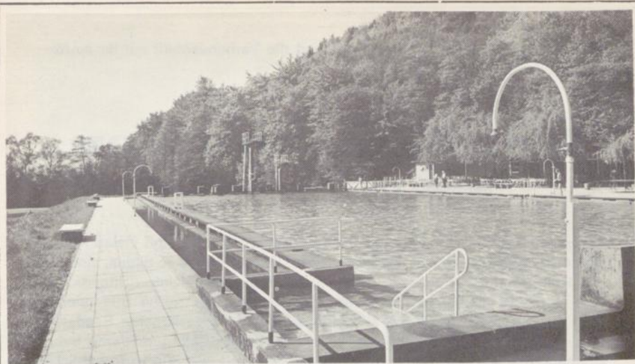
Waldfreibad im Nizzatal mit moderner Wasseraufbereitungsanlage
