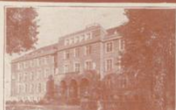
Verwaltungsgebäude Krefelder Stahlwerk
