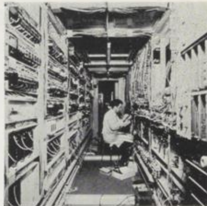
Leitstand für eine Mineralwollanlage in der Fertigung
