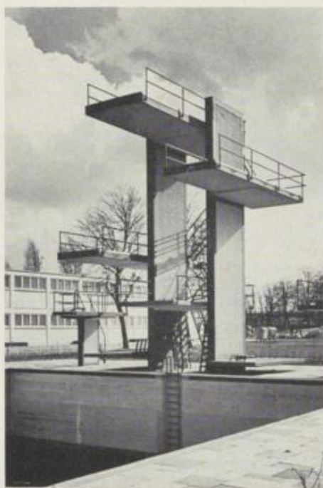
Sprungturmanlage Freibad Stadion Styrum
