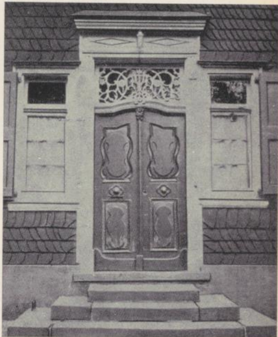
▼ Haustür des alten Pastorats Kaiserstraße 6
