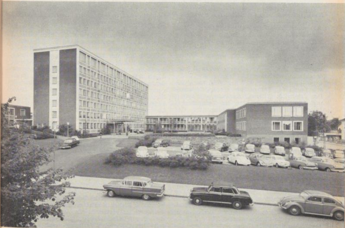
Das neue Kreishaus
