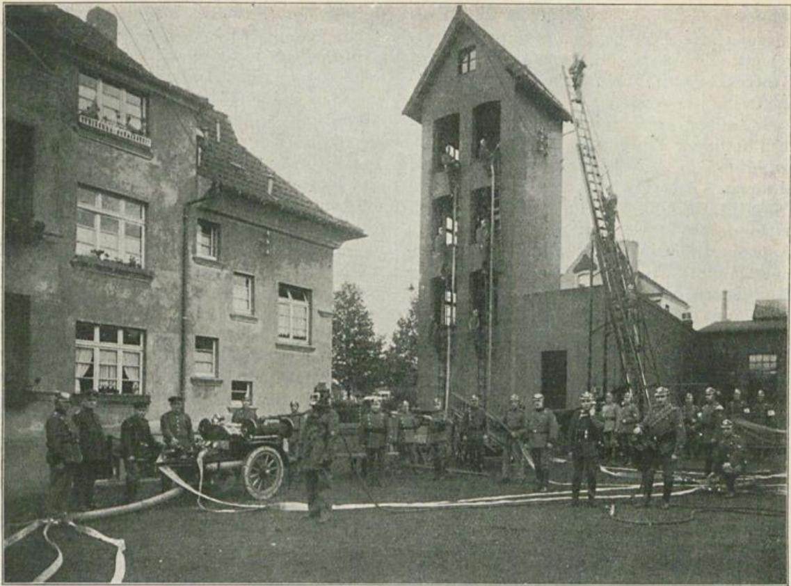
Eine Brandübung am Steigerturm auf dem Hofe des Feuerwehrsiedlungsheimes an der Lessingstraße.
