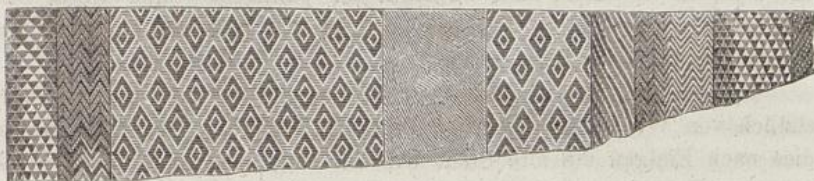
Aeussere Wandbekleidung zu Warka.
