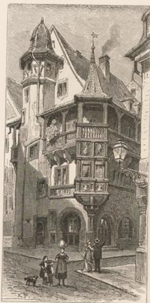
Das Pförthaus in Colmar.
