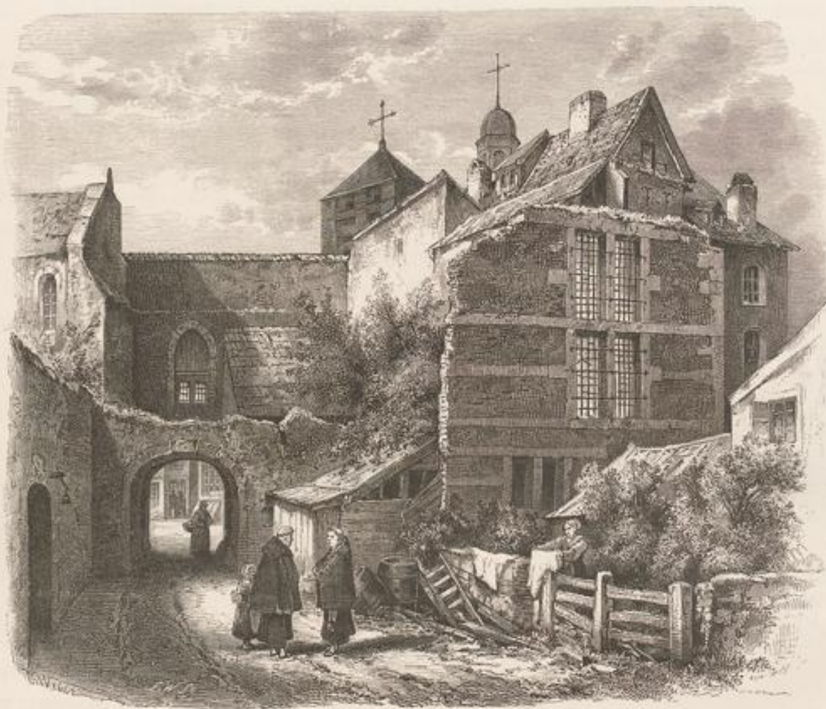
Aachen. Hof des Kornhauses.
