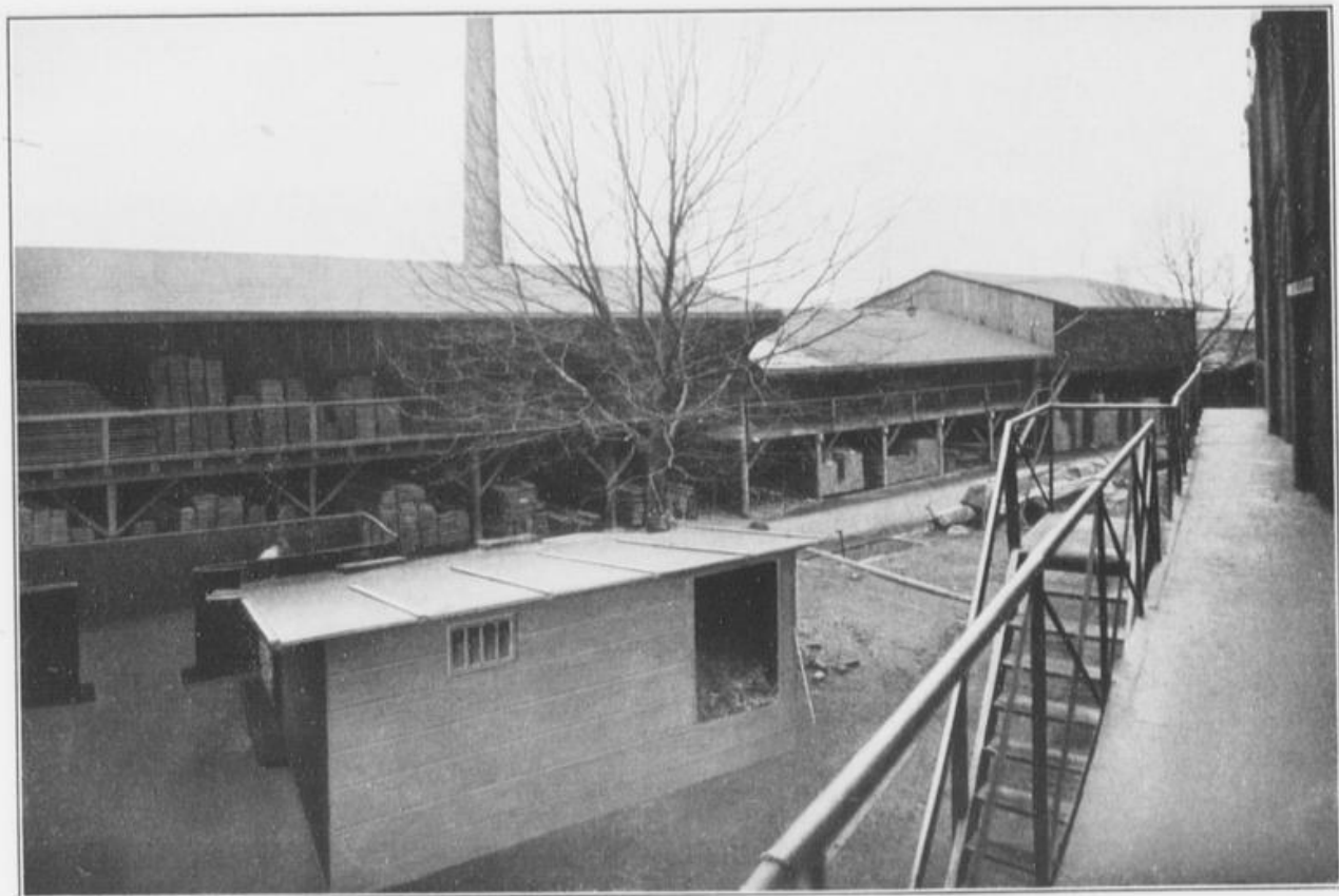
Holzlager West mit Staatsbahn-Anschluß.
