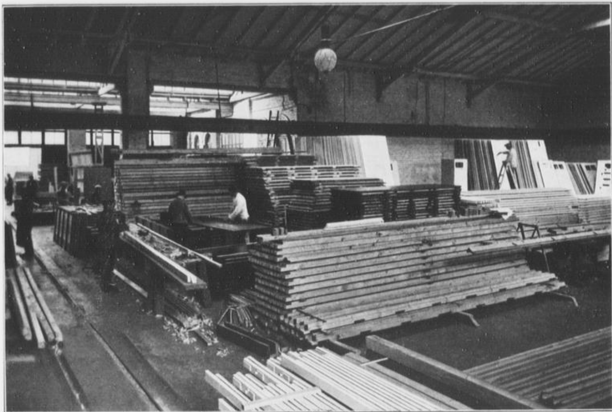
Halle für Anstreicherarbeiten.
