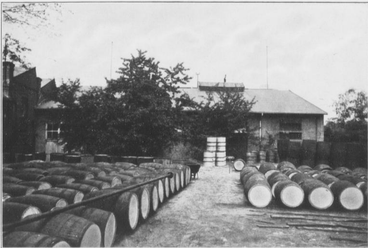
Teerhof und Montagehalle für Barackenbauten.
