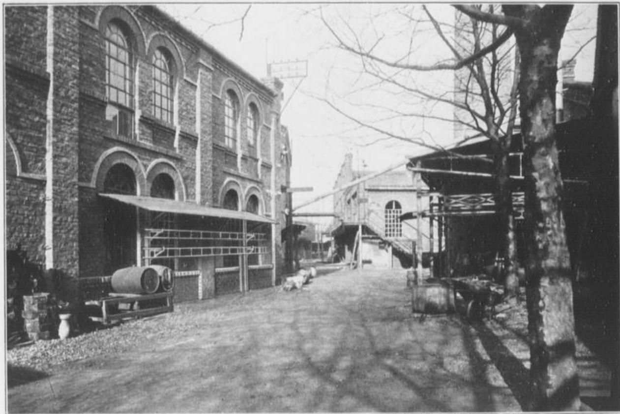
Binnenhof I des Asphalt- und Teerwerks.
