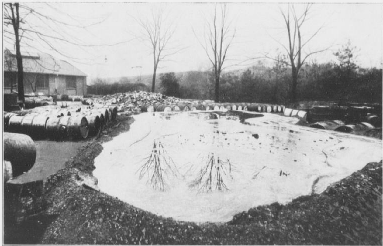
Lagerhof für Asphalte und Pech.
