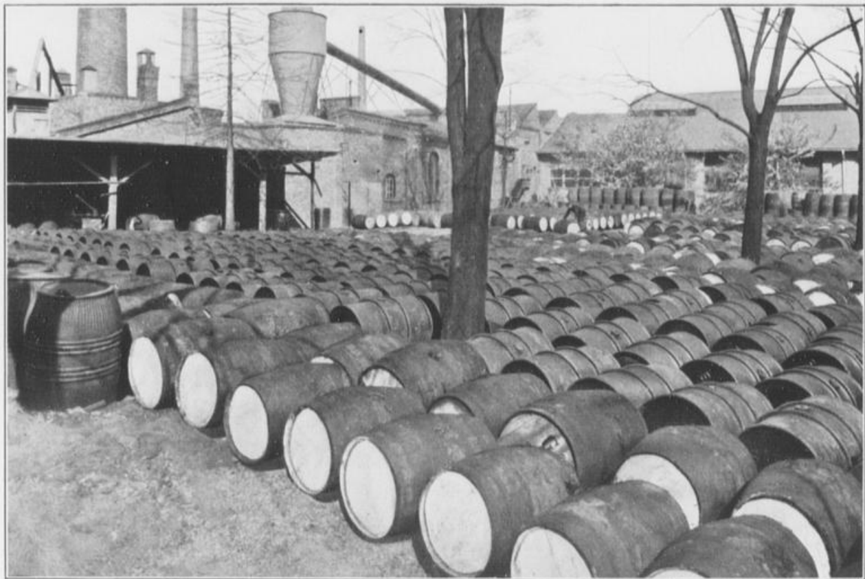
Lagerhof für Asphalte und Teerprodukte in Fässern, im Hintergrund Kesselhaus mit Exhaustoren-Anlage.
