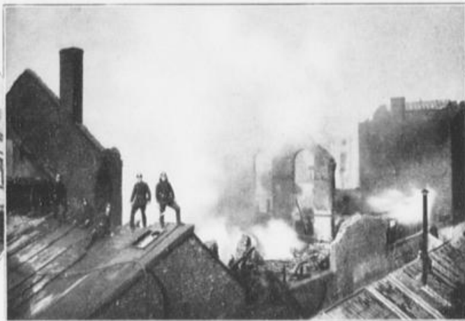
Brand der Fabrik und Lagerhäuser Wehrhahn 27 u. Oststraße 2 6. März 1895.
