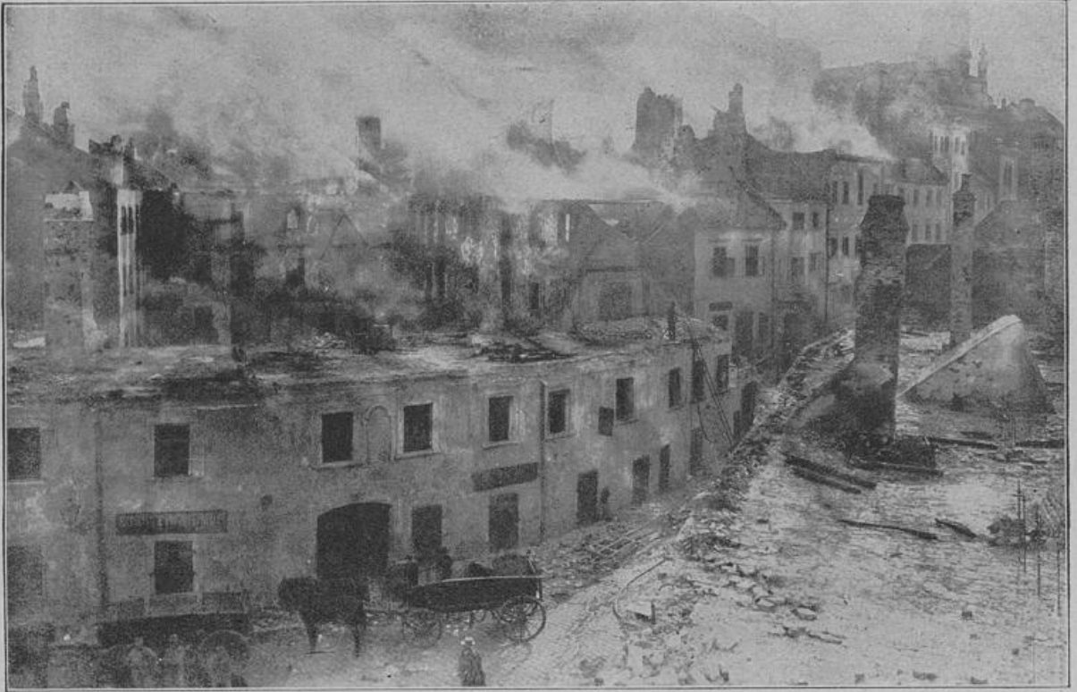
Blick auf die Feuersbrunst in Preshburg, die am 18. Mai ausbrach und über 100 große Steinhäuser, zwei Kirchen sowie zahlreiche öffentliche Gebäude vernichtete. Berliner Ill.-Ztg.
