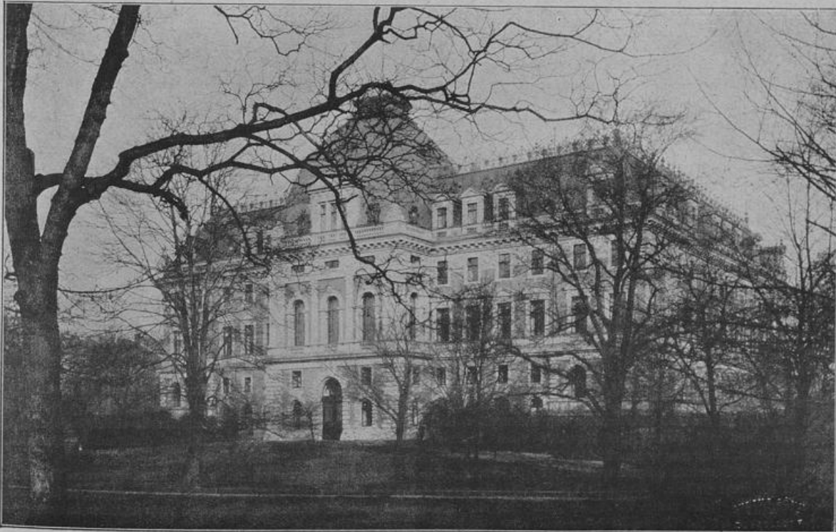
Außersicht des nach dem Entwurf des Architekten Hermann vom Ende umgebauten Provinzial-Ständehauses in Düsseldorf, in welchem am 23. Februar d. J. der neugewählte Provinzial-Landtag zum erstenmal zusammentrat. Hofphot. J. Sohn, Düsseldorf.
