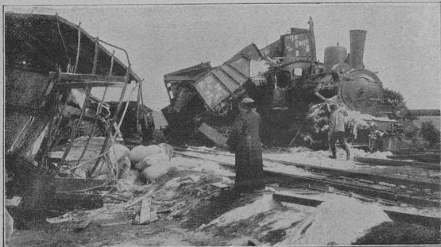
Eisenbahnunglück bei Kargow auf der Strecke zwischen Neustrelitz und Waren.
