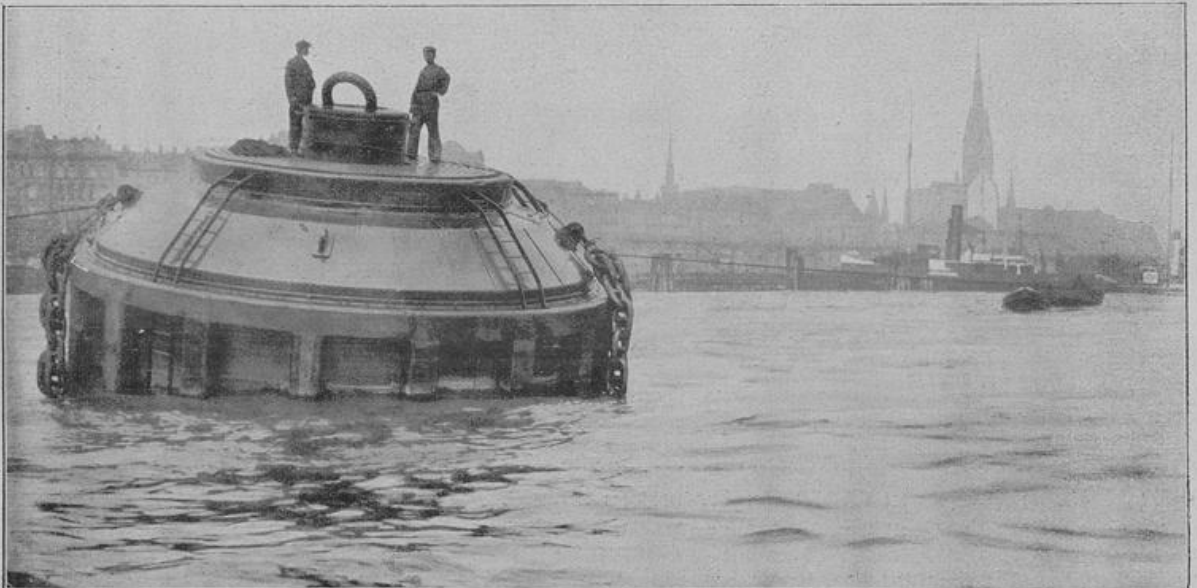
Miesenboje für den zukünftigen Liegeplatz des „Imperators“ auf der Freiburger Reede an der Antarktis bei Hamburg. Die Boje hat 7 m Durchmesser und 6 1/2 m Höhe; die Verankerungskette ist 100 mm stark. Phot. W. Schulz, Hamburg.
