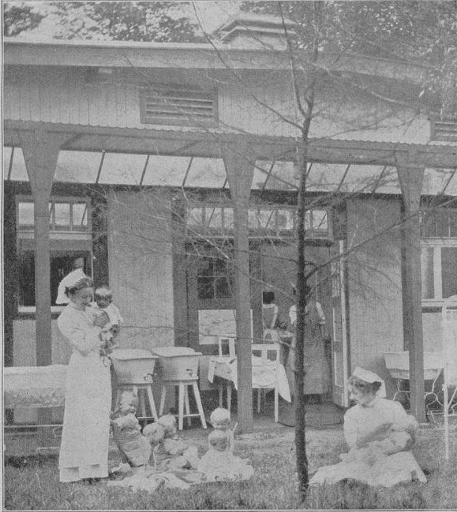
Eine der beiden im Frühjahr d. J. im Schloßpark zu Wehrath errichteten Baracken des Vereins für Säuglingsfürsorge im Regierungsbezirk Düsseldorf.
