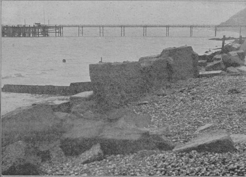
Sturmflut bei Portsmouth: Von den Wogen herausgerissene Mauerstücke am alten Hafen von Portsmouth.
