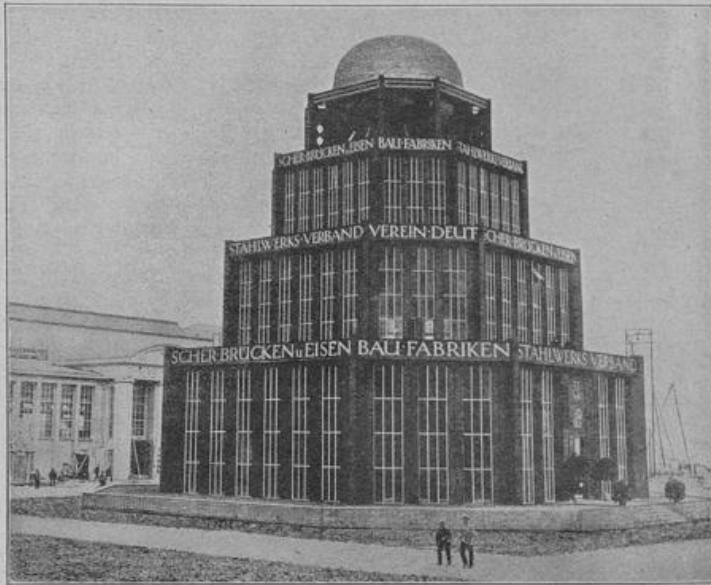
Das Gebäude des Deutschen Stahlwerks-Vereins auf der Leipziger Wausach-Ausstellung, zu dessen Errichtung über 300000 Stahlfestenträger verwendet wurden.
