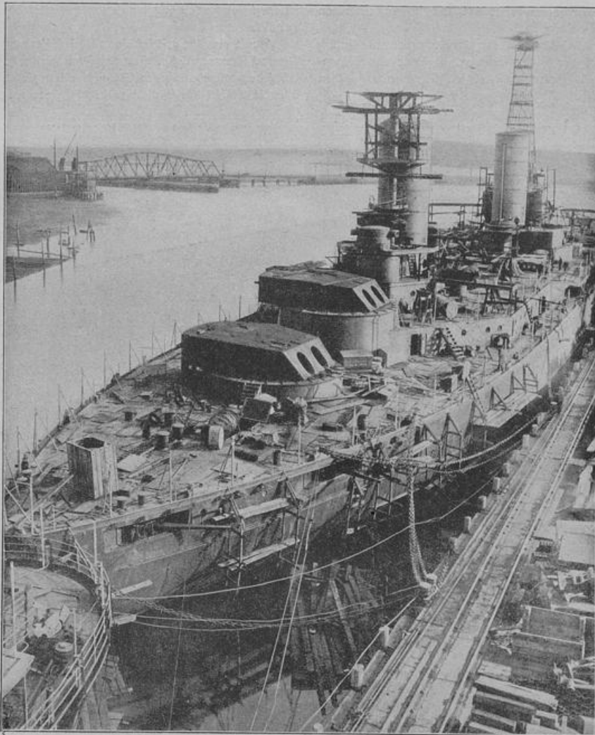
Ein argentinischer Dreadnought im Bau.
