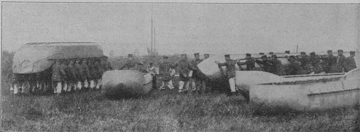
Bau einer 400 Meter langen Pontonbrücke über die untere Oder bei Dammanisch zur Verwendung für Infanterie und Artillerie.
