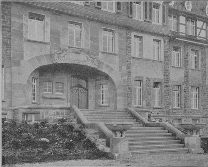
Das Portal des Genesungsheims in Denkfingen.
