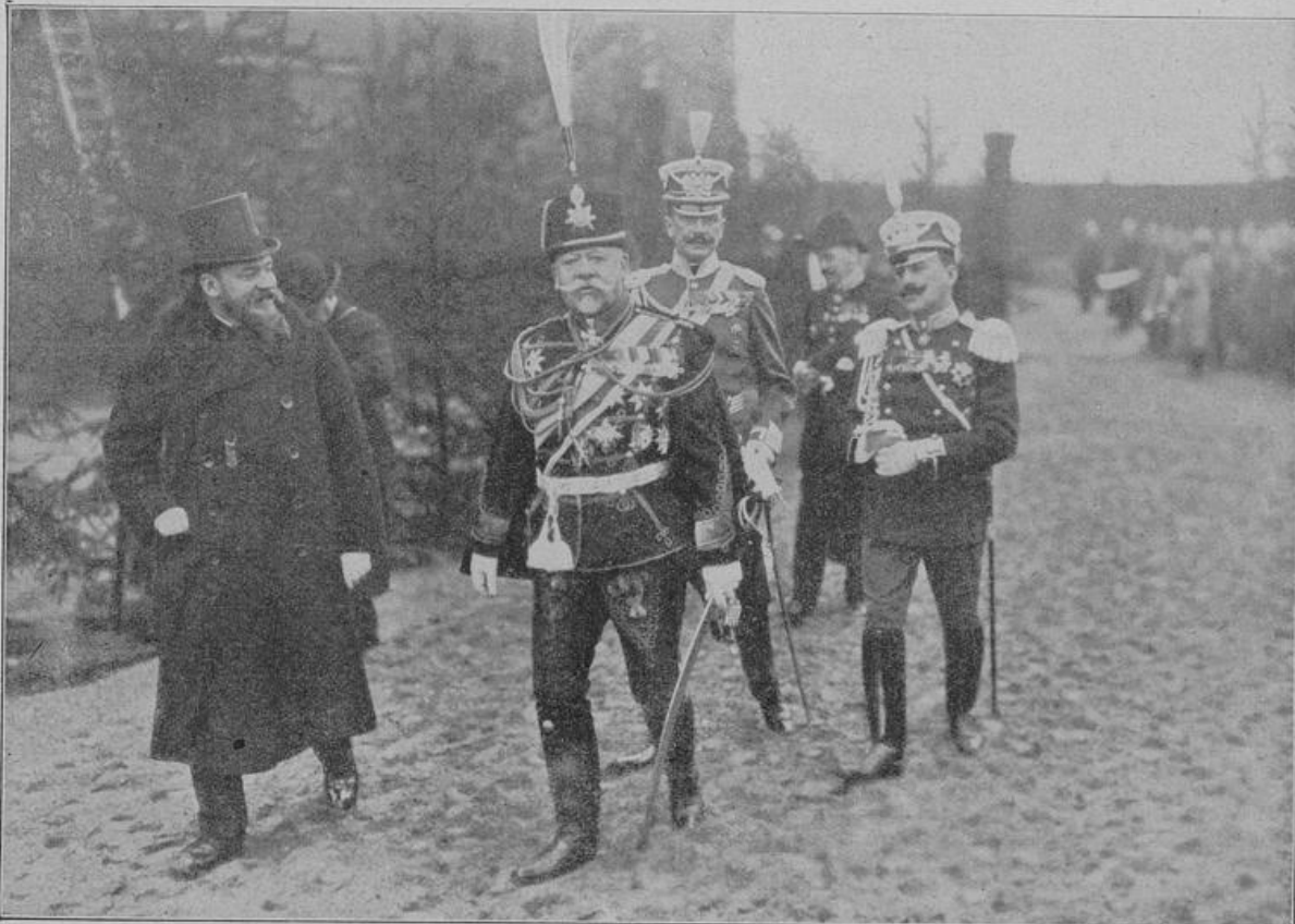
Der russische Kriegsminister Suchomlinow begibt sich zur Grundsteinlegung der russischen Gedächtniskirche auf dem Schlachtfelde von Leipzig, wo 22 000 Russen den Tod fanden. Berliner Illustr.-Gesellschaft.
