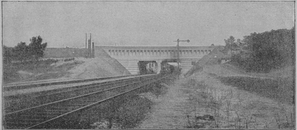
Vom Großschiffahrtsweg Berlin—Stettin: Brückenkanal über die Berlin—Stettiner Eisenbahn. An dieser Stelle ist ein Begegnen von drei Schiffen möglich. Intern. Photo-Archiv, Berlin.
