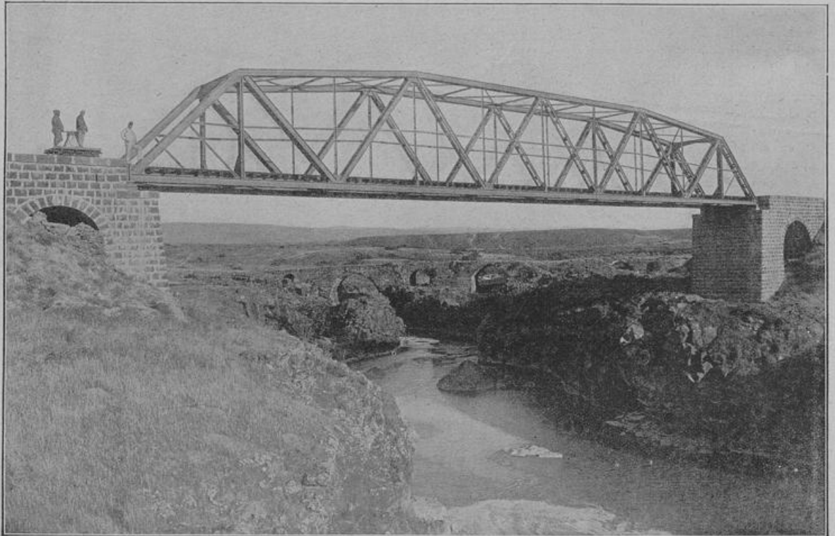
Eiserne Brücke der Hedtschasbahn im Jarmuktal; im Hintergrund eine alte steinerne Brücke.
