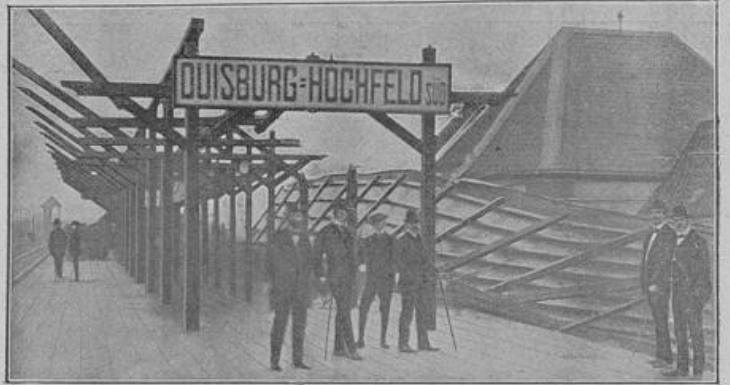
Das am 19. Mai abends 8 Uhr vom Wirbelsturm abgerissene Bahndach aus dem Bahnhof Duisburg-Hochfeld Süd. Phot. p. m. Müller.
