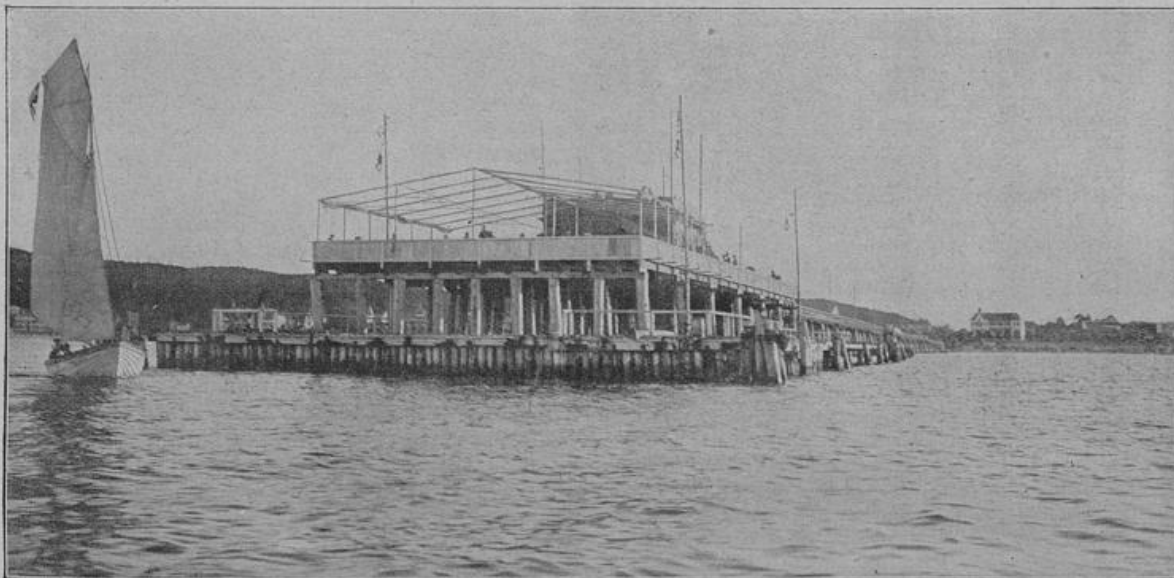
Die Landungsbrücke in Binz auf der Insel Rügen, die am 28. Juni einstürzte, wobei etwa 200 Personen in die See fielen, von denen 14 den Tod fanden.
