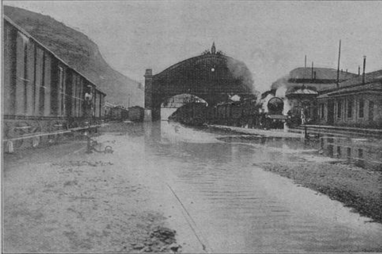
Der Bahnhof von Ventimiglia durch das letzte Anwelken an der Riviera unter Wasser gesetzt.
