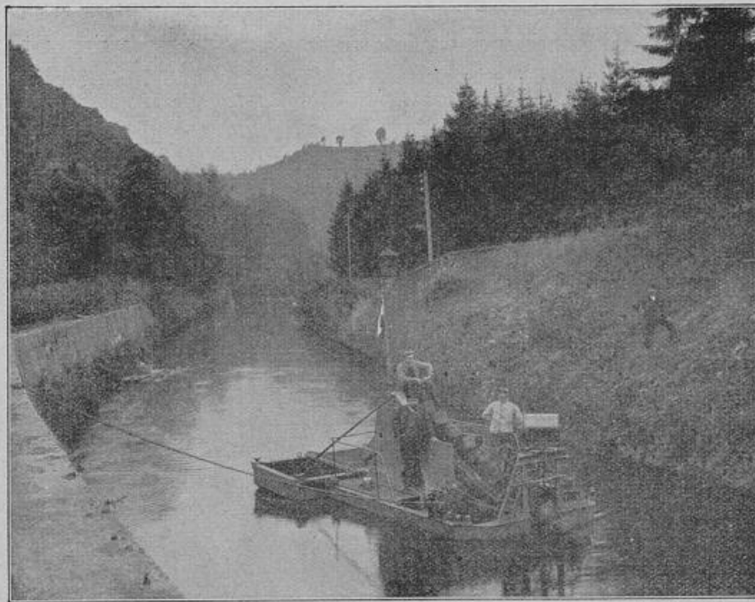
Der erste Bagger auf der Zupper, der an dem Bergischen Elektrizitätswerk, Centrale Müngsten, am Fuße der Kiesenbrücke aufgestellt ist.
