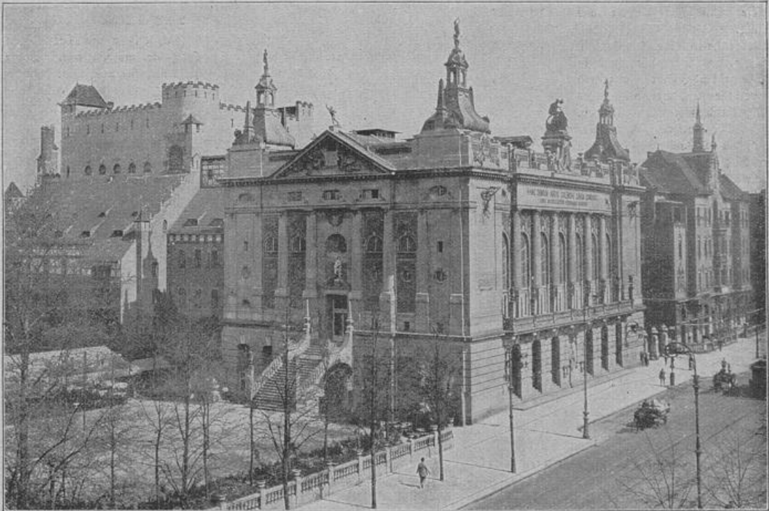
Das am 25. August von einem Brande heimgesuchte Theater des Westens in Charlottenburg.
