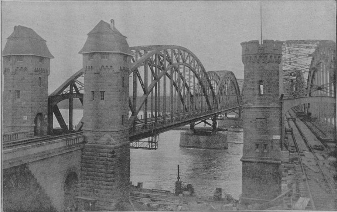
Die beiden Düsseldorfser Eisenbahnbrücken bei Hamm, links die neue in ihrer Vollendung, rechts die alte, 1868—70 erbaute, im Umbau. Jean Esser, Düsseldorf.
