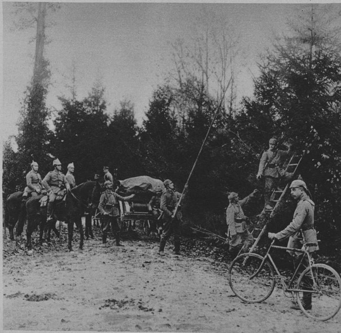
Legen einer Feld-Telephonleitung über die Wipfel der Bäume durch deutsche Soldaten auf dem Kriegsschauplatz.
