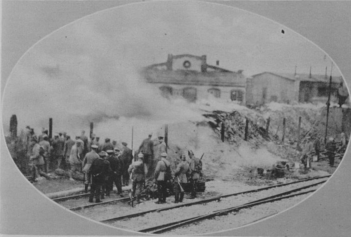
Das von den Russen angezündete Riesen-Steinkohlenlager auf dem Bahnhof in Angerburg.
