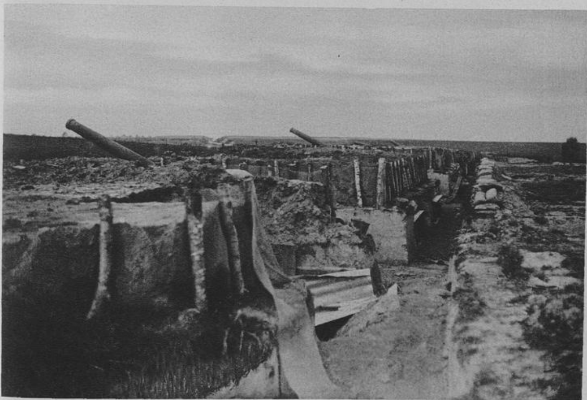
Blick in eines der von den Engländern verlassenen Festungswerke von Antwerpen.
