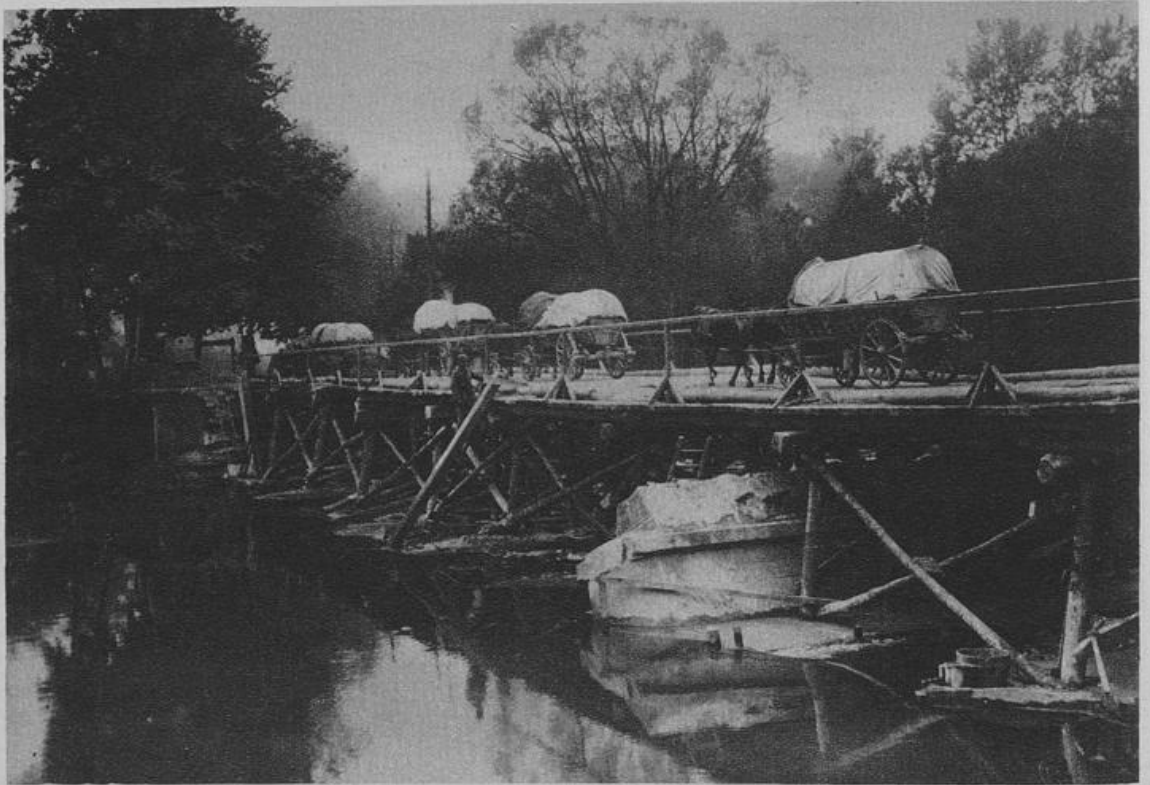
Vom Übergang der Deutschen über die Maas bei Stenay: Bagagewagen passieren die Brücke, die von den Franzosen gesprengt worden war, von unsern Pionieren aber wiederhergestellt wurde.
