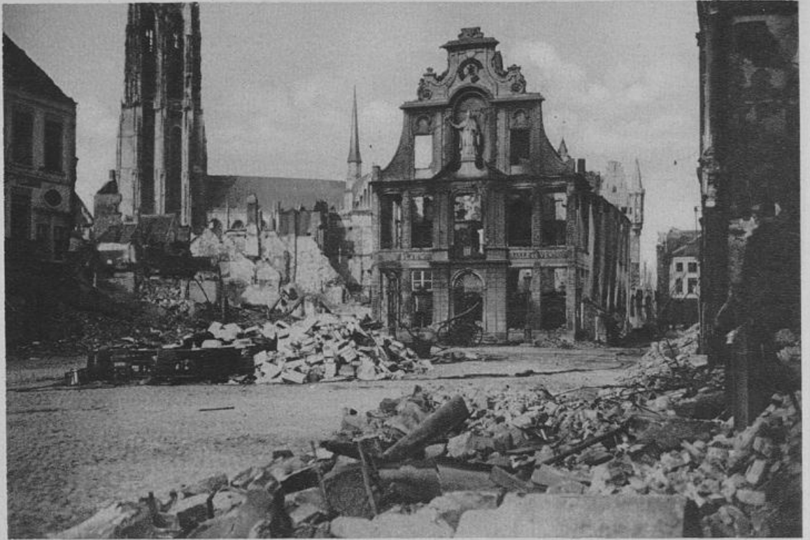
Strafe in Mecheln nach der Beschießung. Links die nur leichtbeschädigte Kathedrale.
