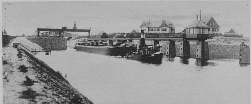
Schleuse I bei Duisburg. Sämtliche Bauten wurden errichtet von der Brückenbau-A.-G. Hein, Lehmann & Co., Düsseldorf.
