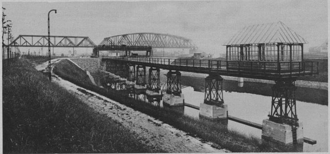
Schleusenanlagen des Rhein-Herne-Kanals bei Dettwig.
