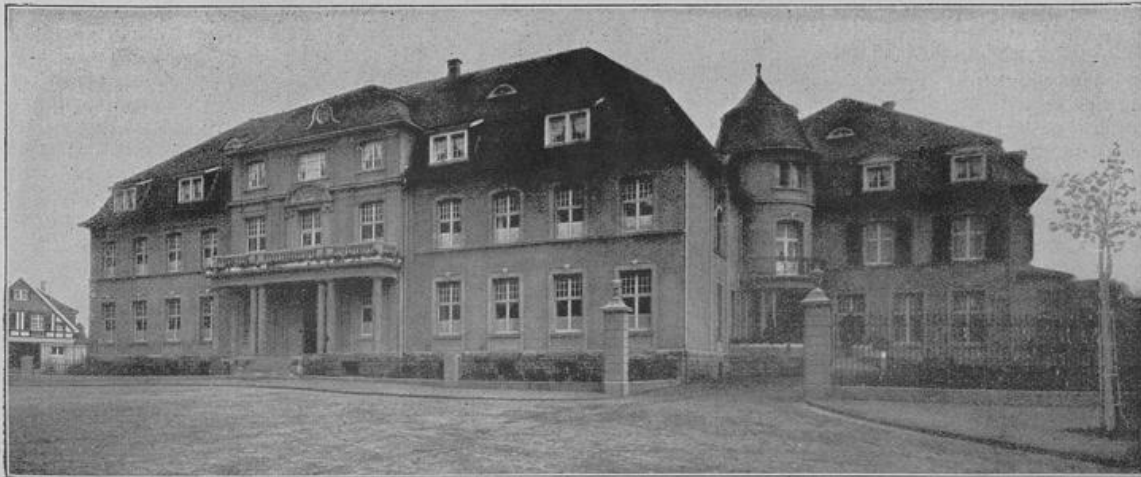
Das nach den Plänen von Professor Alohbach (Barmen) erbaute Landratsamt des Kreises Solingen in Opladen. E. Birkel, Elberfeld.
