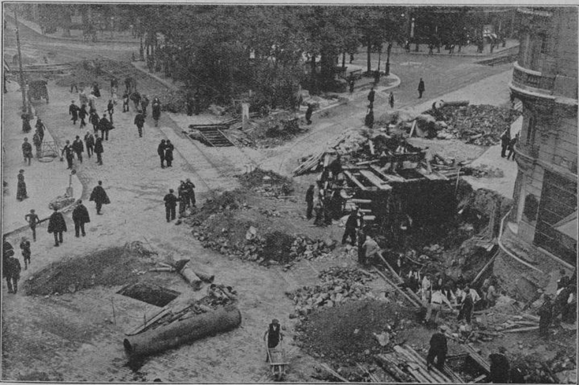
Von der Anwerkerkatastrophe in Paris: Abersicht über die Erdsenkungen im Viertel St. Philippe du Roule, wo der Hauptkanal pflachte. In der 150 qm großen Senkung rechts wurden fünf Leichen gefunden.
