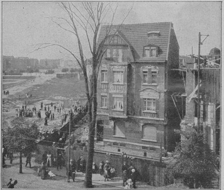
Verhiebung eines Hauses in Duisburg.
