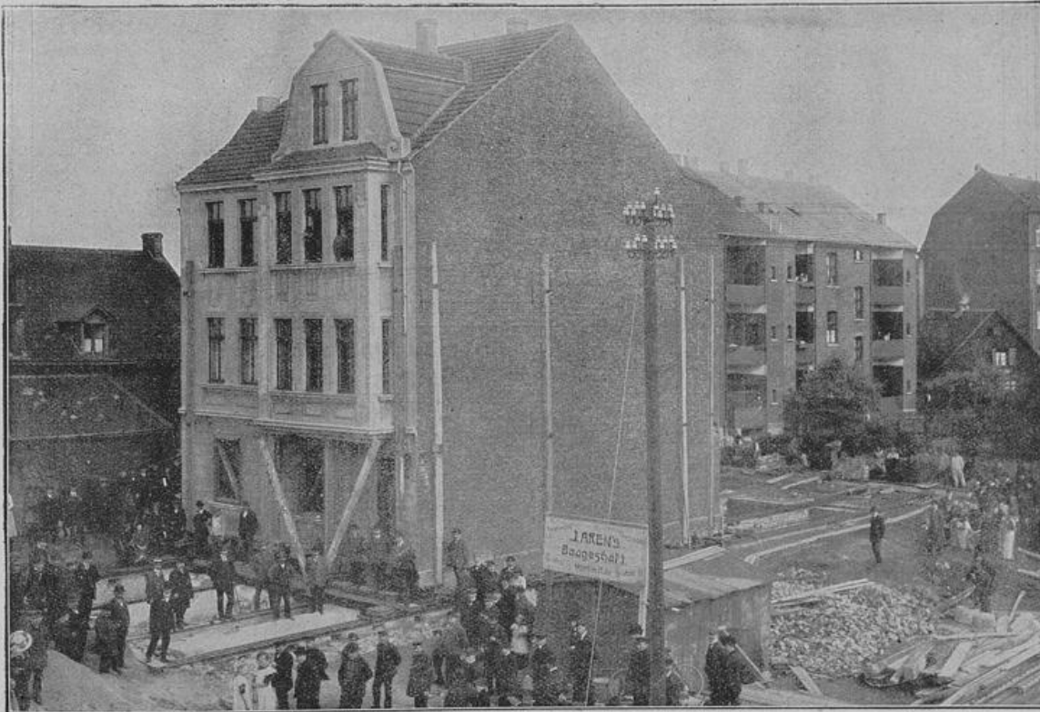
Verchiebung eines Hauses in Wülhelm-Styrum.
