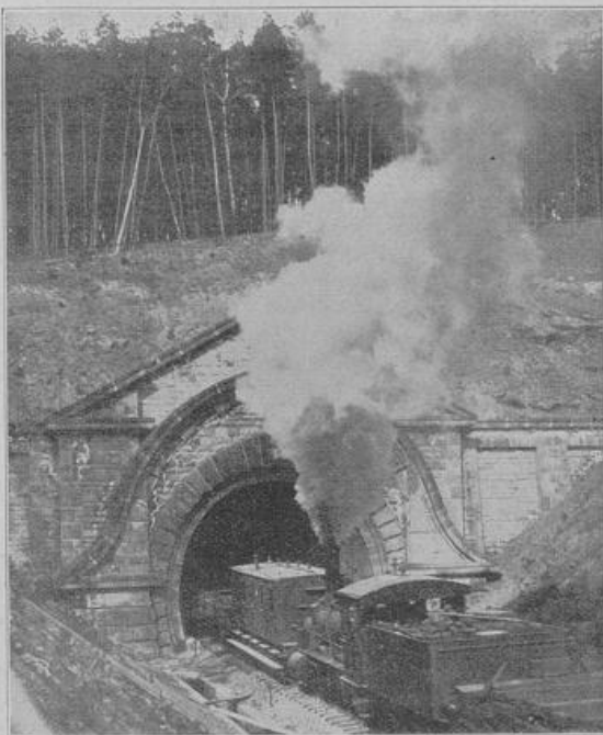
Eröffnung des Dieselfrasen-Tunnels bei Schlüchtern am 2. April. Dieser Tunnel, der zweitgrößte Deutschlands, wurde jetzt nach sechsjähriger Bauzeit fertiggestellt. Er ist 5575 m lang und kostete zehn Millionen Mark. Durch ihn wird die Strecke Berlin—Frankfurt a. M. bedeutend abgekürzt.
