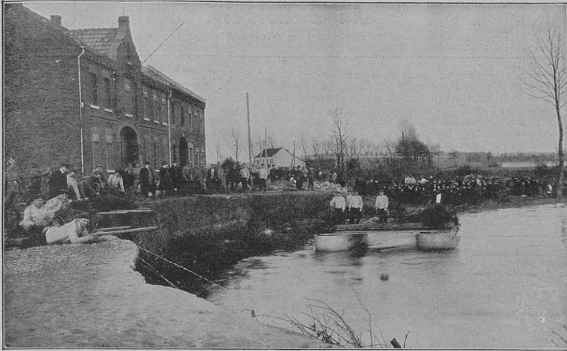
Verheerung durch Hochwasser der Roer an der Landstraße Hüddelhoven—Gilsarth.
