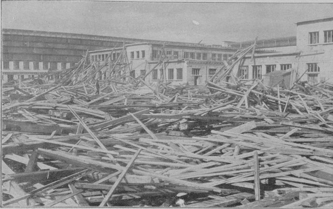
Die Pavillons der Ausstellung in Lyon nach dem Orkan am 22. Februar.
