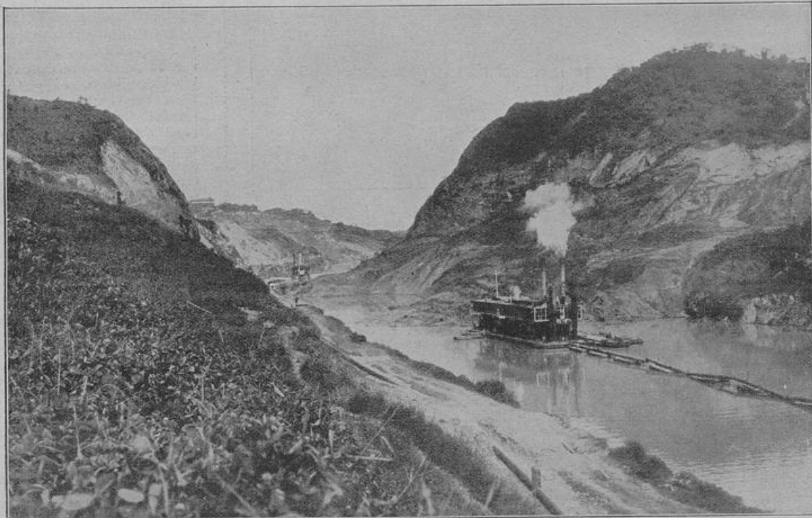
Ein Driesenbagger im Panamakanal bei dem jüngsten Bergsturz bei Culebra.
