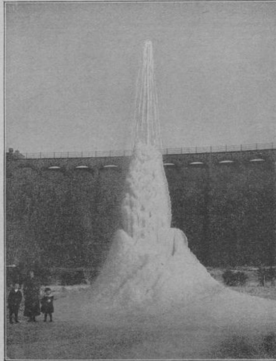
Der Springbrunnen an der Nevelasperrre bei Wippersfärth bildet zurzeit eine über 8 m hohe Eispyramide. Infolge des starken Druckes (die Stauhöhe ist 24 m über der Talsohle) hält sich der Wasserstrahl frei. Emil Hardt, Wippersfärth.
