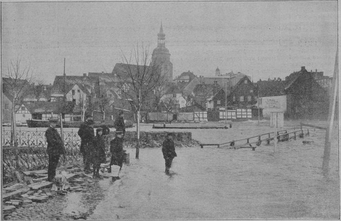
Ueberschwemmung in Wolgast.
