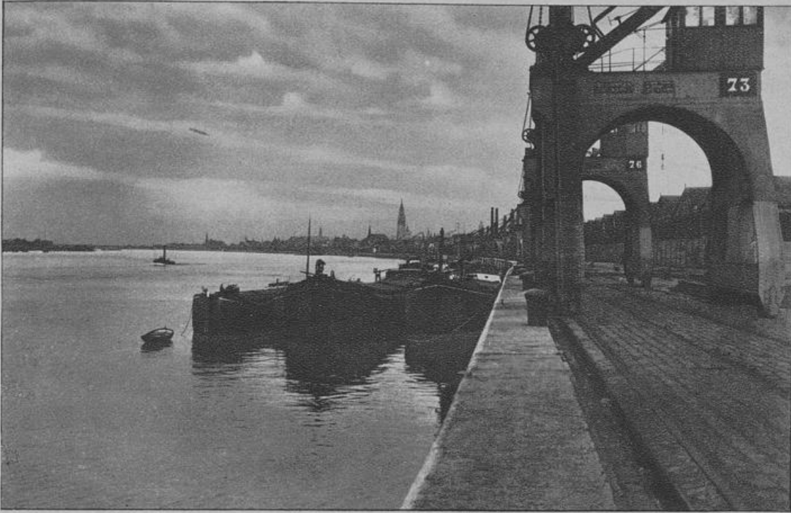
Ein Blick über die riesigen Kaiflächen an der Schelde: Im Vordergrund einige Portalfrane. Phot. B. Wiele.
