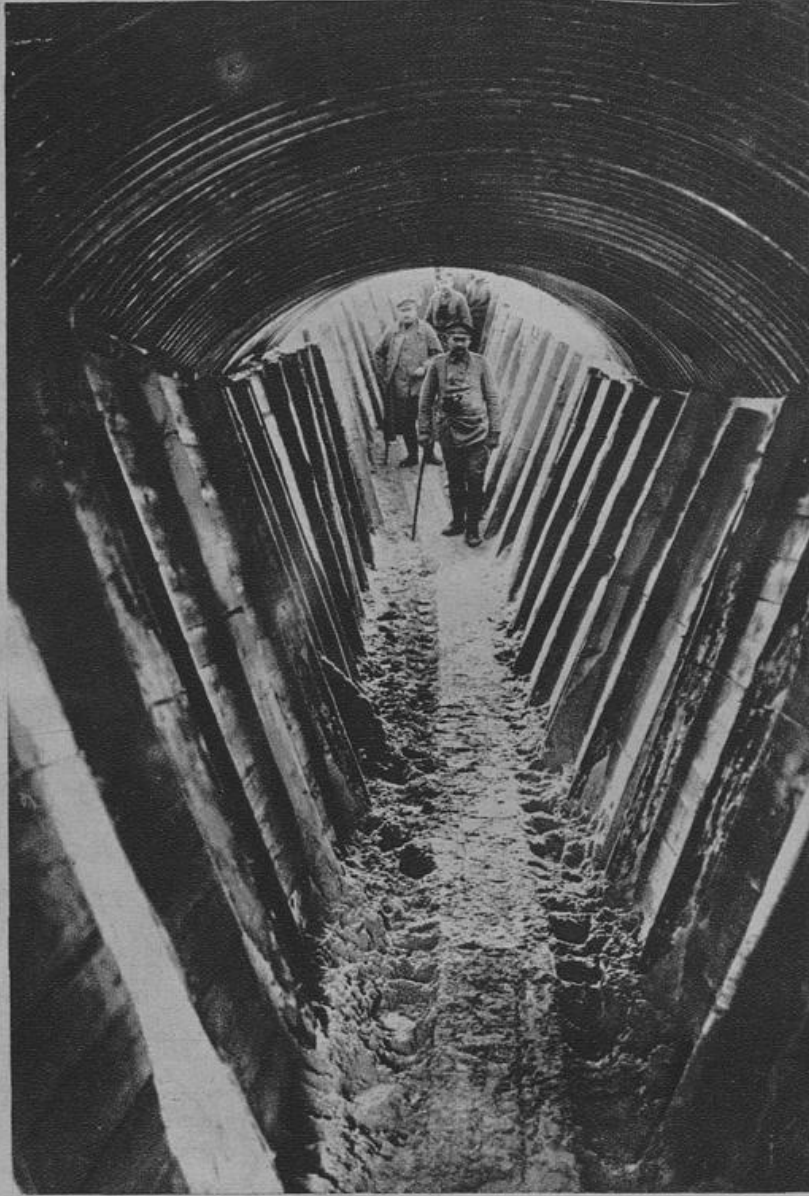
Ein ein Kilometer langer, bombensicherer Tunnelaufgraben, der bis zu den vordersten Schützengräben führt.
