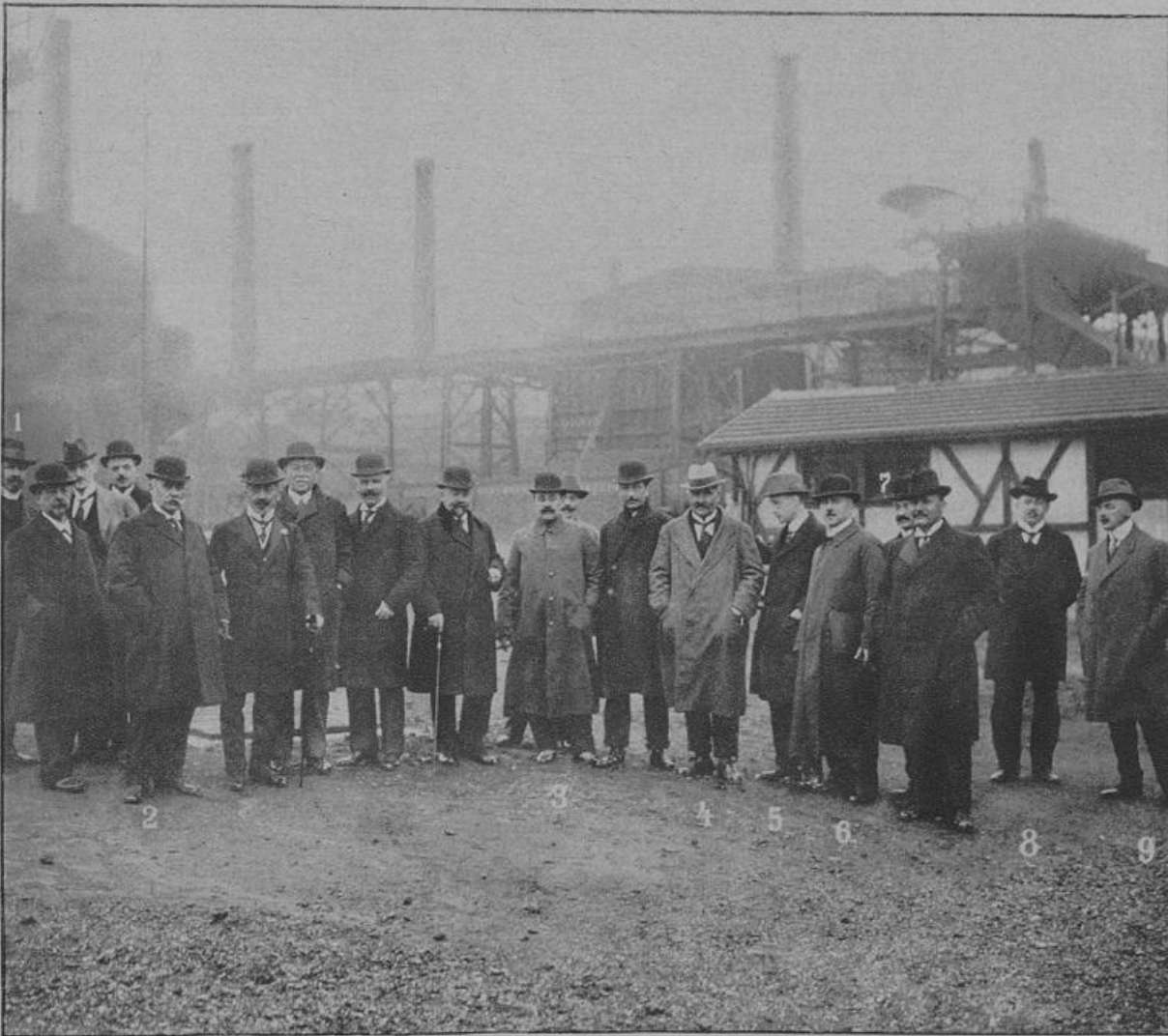
Besichtigung der Schachtanlage 3 VII der Gewerkschaft „Deutscher Kaiser“ in Hamborn durch die bulgarischen Sobranje-Abgeordneten. Hofphot. Julius Sohn.
