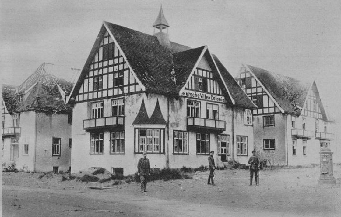
Beschädigte Häuser der deutschen Kolonie in Westende-Bad.
