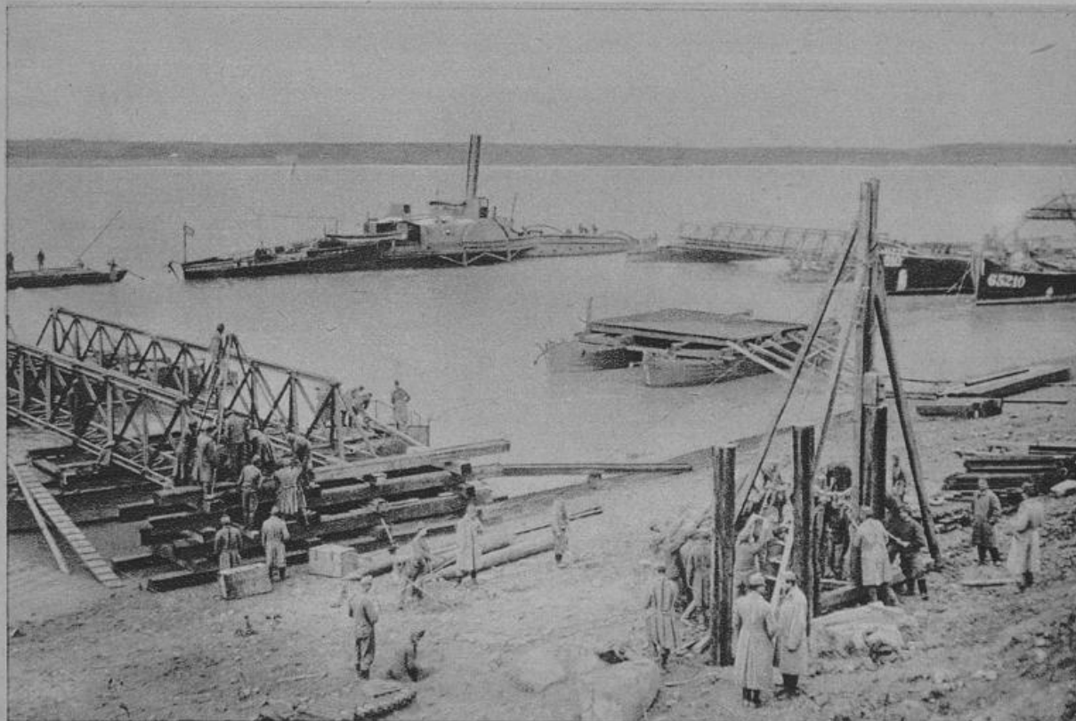
Donau-Übergang Madensens bei Svisslov: Bau der Pontonbrücke für den Einmarsch der Truppen in Rumänien.
