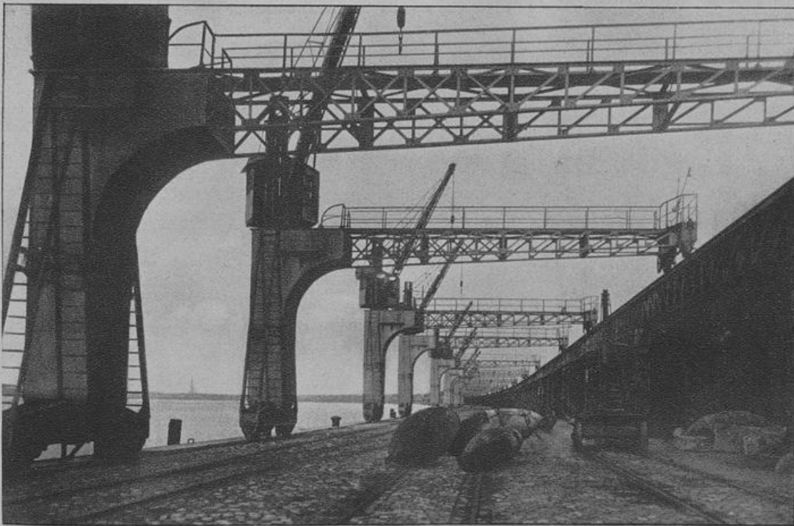
Die zahlreichen Halbportalfrane bestreichen Schiffe, Eisenbahngleise und Schuppen.
