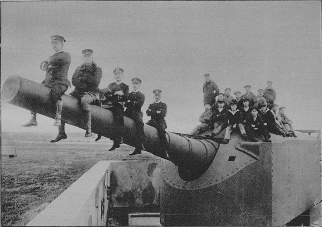
Luftiger Morgenritt bei der Batterie „von Hindenburg“.
