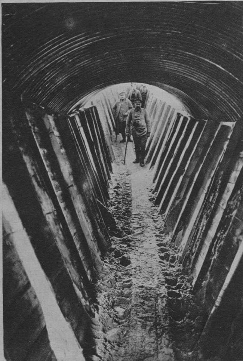
Ein ein Kilometer langer, bombensicherer Tunnelaufgraben, der bis zu den vordersten Schützengräben führt.
