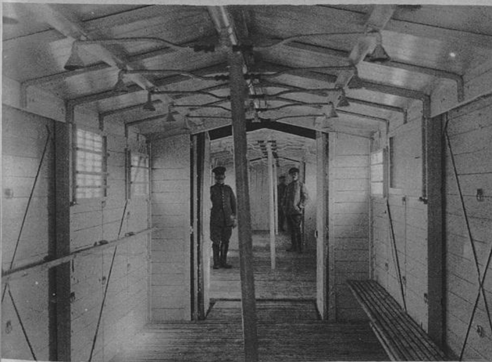
Das Innere eines Badewagens des Badezuges des 1. bayr. Reservekorps. Phot. W. Braemer, Berlin. Jeder Wagen enthält 16 Brausen, der dritte Wagen 10 Brausen und ein Wannensbad.
