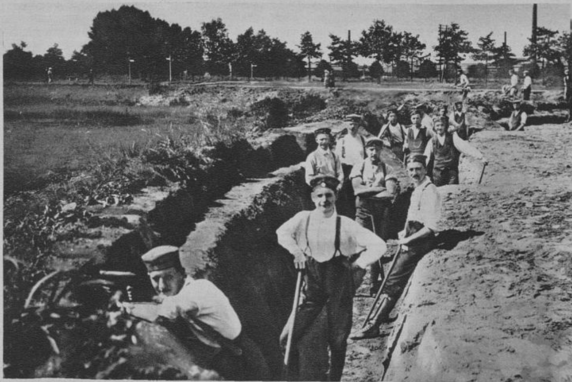
Die Landsturm- und Rekrutenkompanie des Freiwilligen-Rgts. Düsseldorf beim Ausheben von Schützengräben.
