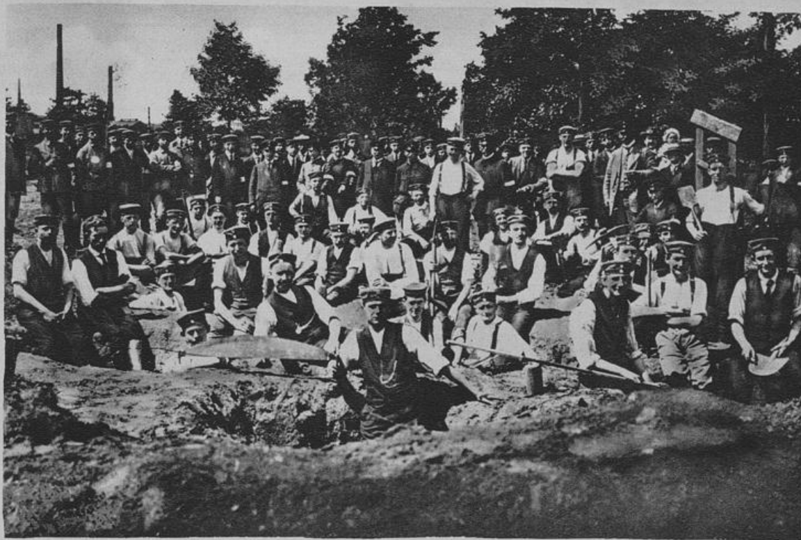
Die Landsturm- und Rekrutenkompanie des Freiwilligen-Rgts. Düsseldorf beim Anlegen von Wolfsgruben. Phot. Max Scholz
