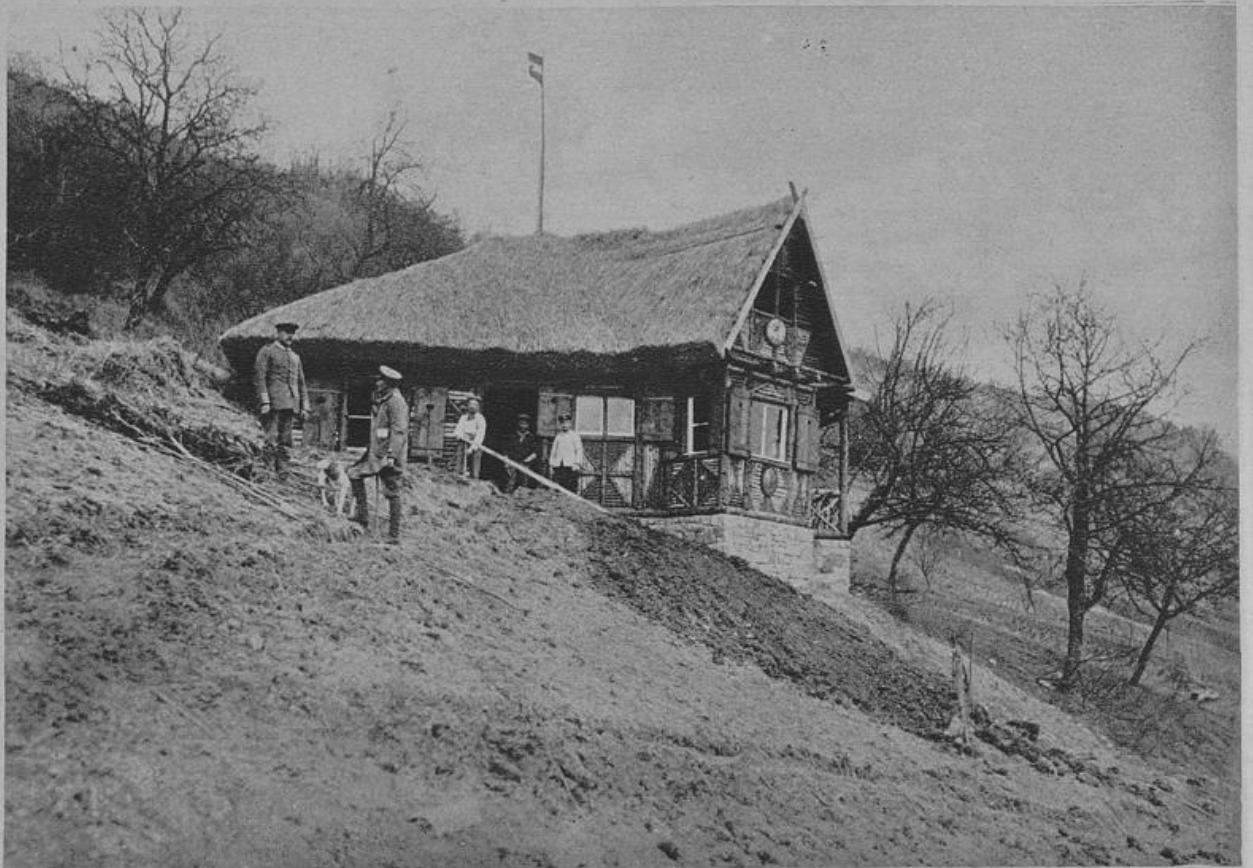
Ein angenehmes Offiziersquartier im Kampfgebiet zwischen Maas und Mosel: Eine Schwarzwaldvilla, die von den Mannschaften einer Kompagnie in den Tagen ihrer Ablösung erbaut wurde.
