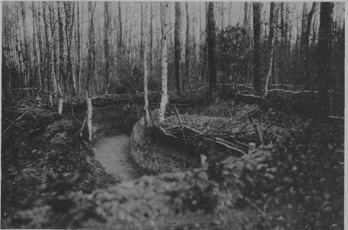
Blick in einen Laufgraben in den Argonnen, der die Verbindung zwischen zwei Schützengräben herstellt.
