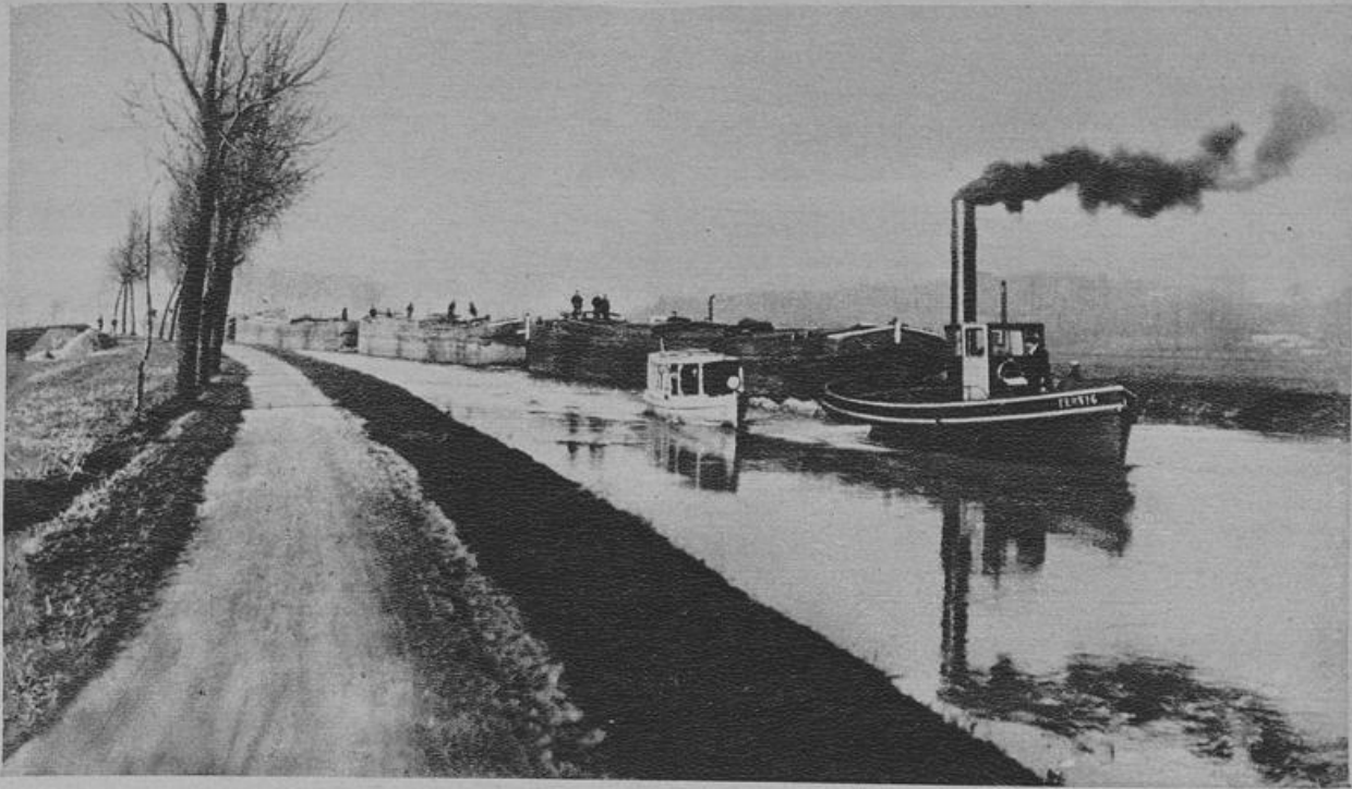
Begleitung eines Schlepptransportes auf einer Wasserstraße in Belgien: Kähne mit Proviant werden zur deutschen Front befördert.
