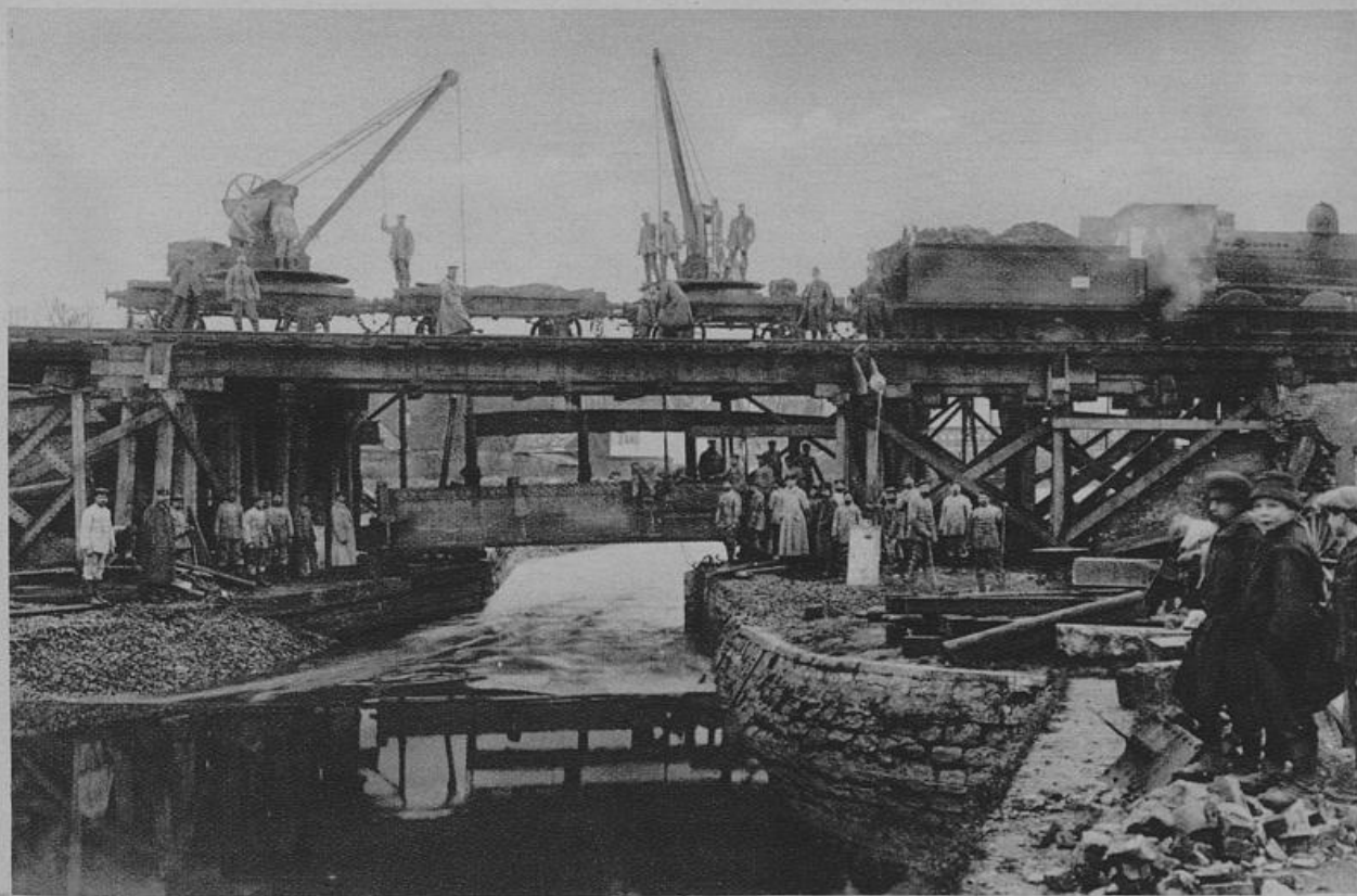
Belastungsprobe einer durch unsere Eisenbahnkompagnien wiederhergestellten Eisenbahnbrücke in Nordfrankreich.
