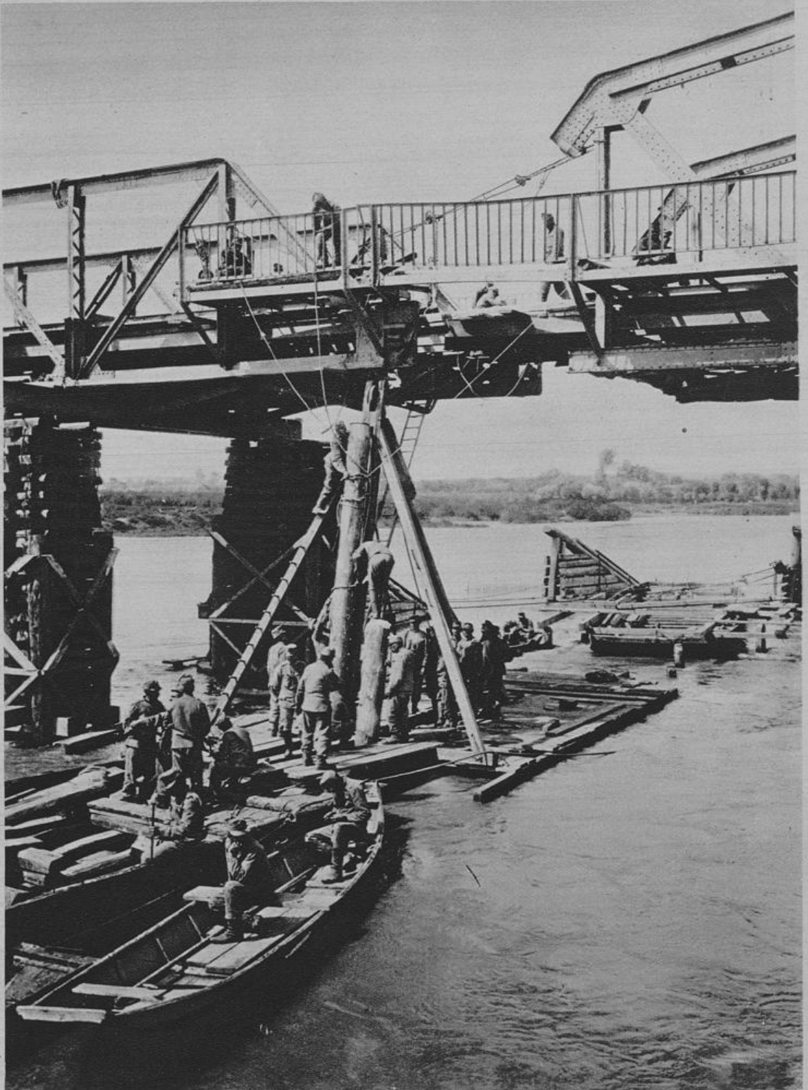
Auf der Verfolgung der Russen: Oesterreichisch-ungarische Pioniere machen die zerstörte Eisenbahnbrücke über den Dniestr bei Halicz wieder betriebsfähig.
