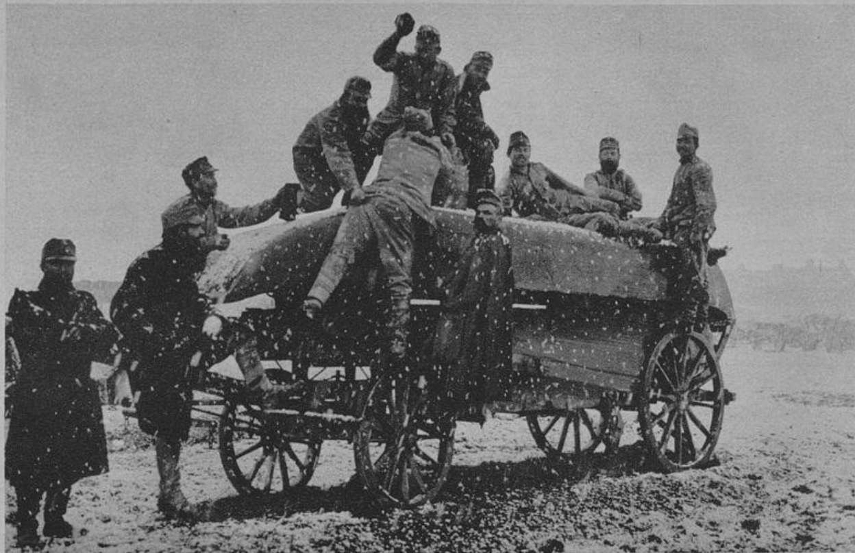
Österreichischer Brüdentrain in Galizien. Pioniere beim Abladen eines Kahnes am Dunajec.
