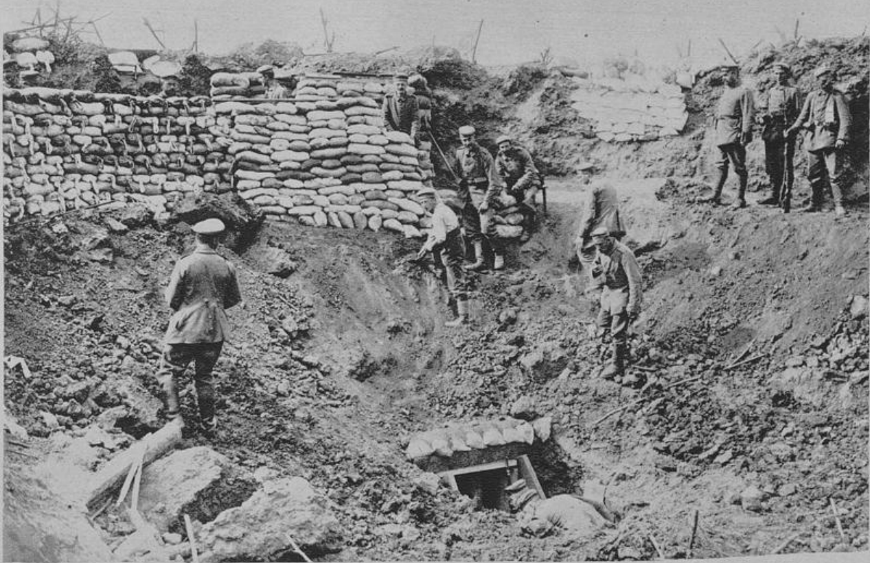
Ein gesprengter französischer Schützengraben wird von unseren Soldaten neu ausgebaut und mit Sandjäden befestigt.
