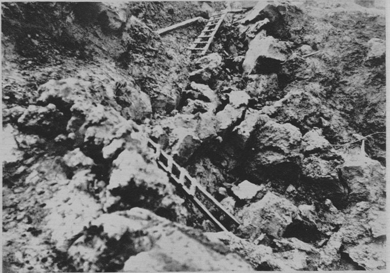
Ein französischer Schützengraben, der durch deutsche Pioniere in die Luft gesprengt wurde. Phot. Leipz. Presse-Büro. Die Trümmerflätte, die fast wie eine Hochgebirgslandschaft anmutet, haben unsere Feldgrauen durch Anlegen von Leitern und Drahtseilen wieder zugänglich gemacht.
