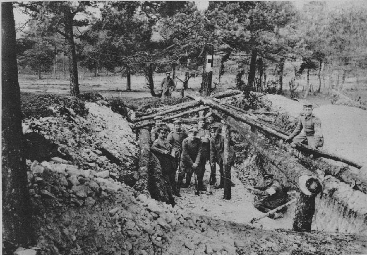
Anlage eines bombensicheren Verbandsplatzes unmittelbar hinter der Front im Westen.
