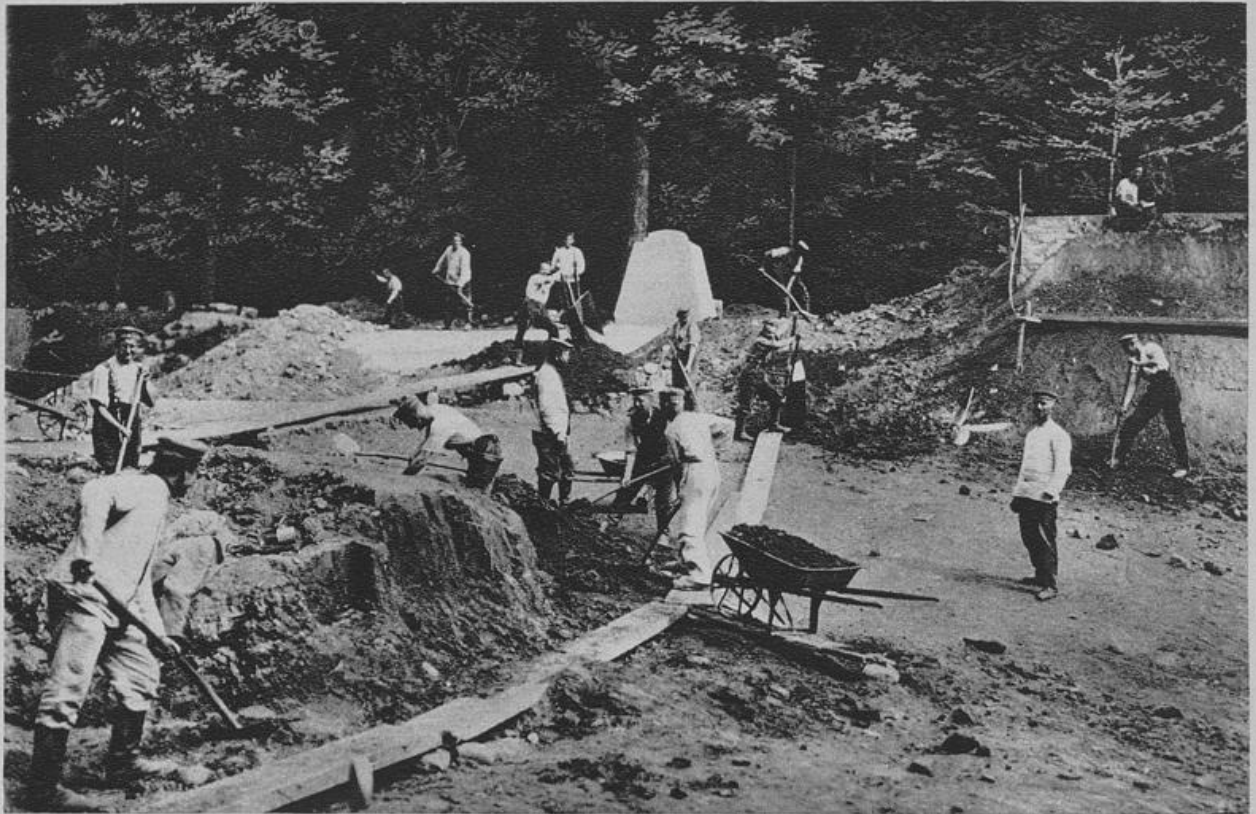
Unsere Feldgrauen beim Anlegen einer Wasserleitung in den Vogesen; im Hintergrund der fertige Hochbehälter.
