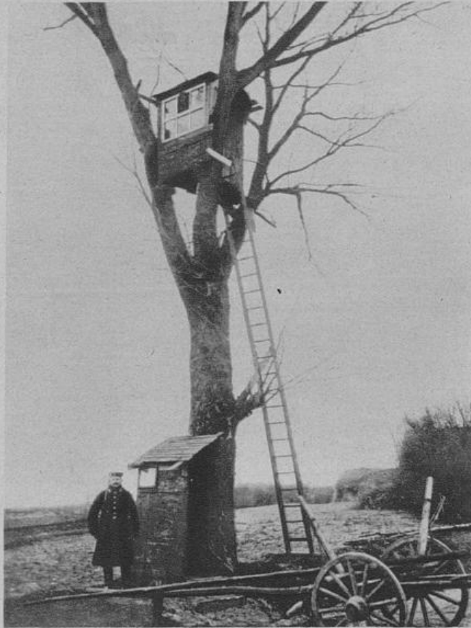
Ein wetterfestes Ausguckhäuschen in einer Baumkrone auf dem Kriegsschauplatz.
