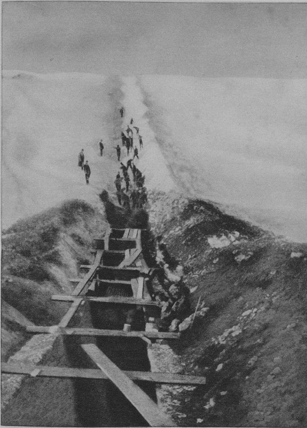
Bau von Schützengräben und Unterständen im Hochgebirge.
