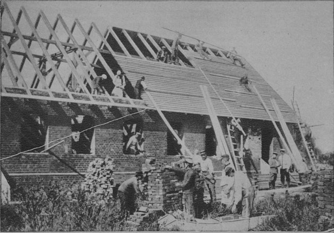
Wiederaufbau Ostpreußens: Kriegsgefangene beim Hausbau in Schöterlaufen bei Gumbinnen. Hofphot. Mühlentisch. Alle beim Wiederaufbau der durch die Russen zerstörten Gebäude beschäftigten Arbeiter werden ihren Leistungen entsprechend entlohnt.
