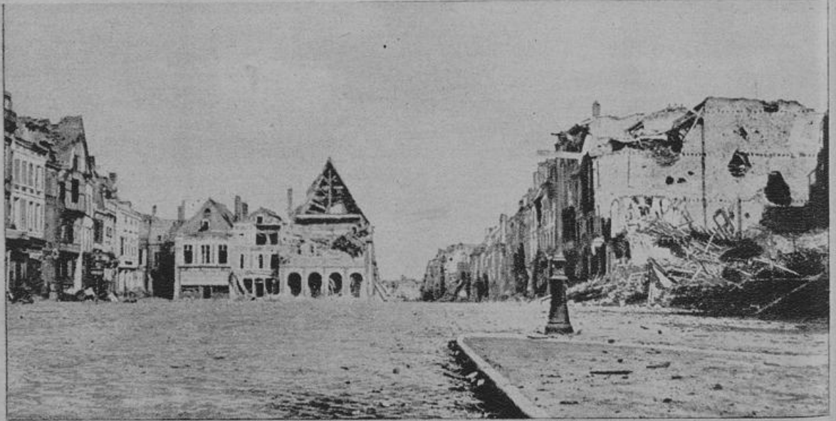
Rückverlegung der Westfront: Der von Artillerie zerstörte Marktplatz von Peronne. Holphot. G. Becker, Potsdam.
