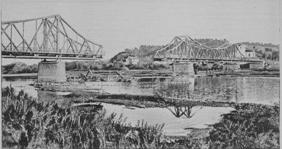
Auf dem Vormarsch im Osten: Von den Russen gesprengte Straßenbrücke bei Halicz.
